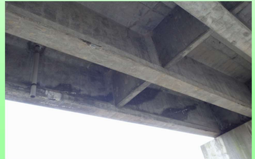
【シース(PC鋼材)に沿った水の浸入による変状事例】
