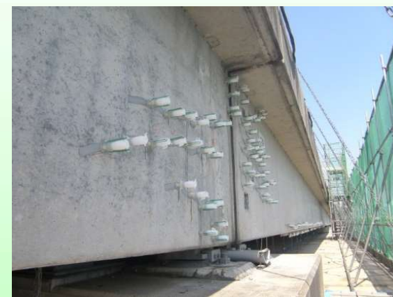
写真5.4.3 ひび割れ注入工
