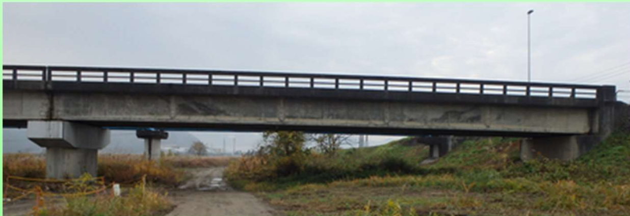
【シース(PC鋼材)に沿った水の浸入による変状事例】
