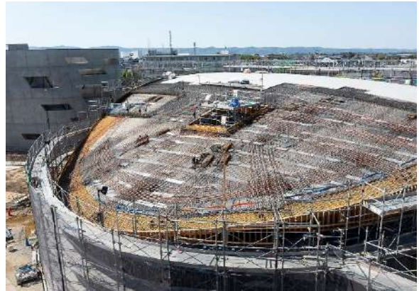
写真 - 15 配筋およびPC鋼材配線状況
