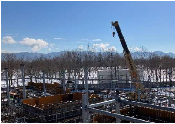
写真 - 12 森の木々と連続する鉄骨柱
