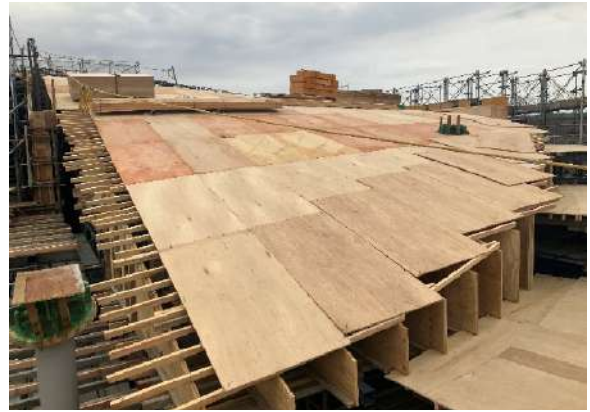
写真 - 13 楕型枠の組立状況
