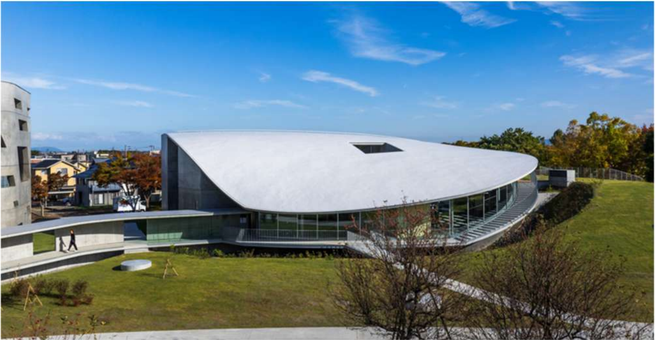
写真-1 周辺ランドスケープと既存の校舎群を機能的・景観的に滑らかに連続させる第4アトリエ棟
