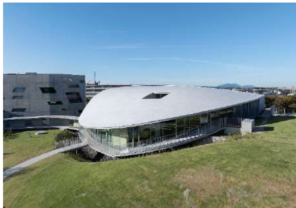
写真 - 18 浮かぶ大屋根 (南東より)
