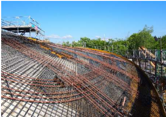
写真 - 14 配筋およびPC鋼材配線状況
