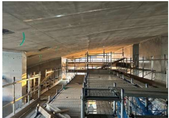
写真 - 17 屋根スラブ打設後の内部足場の状況
