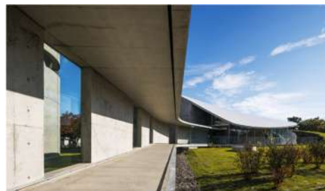
写真-5 第3アトリエ棟からの連続性
