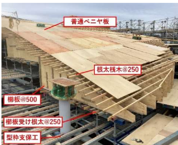
写真 - 7 型枠の組立構成
