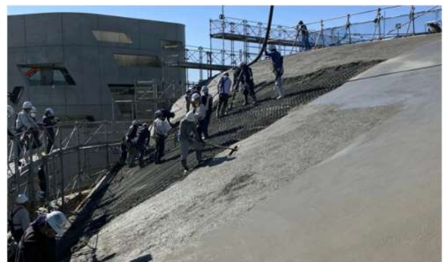
写真 - 11 コンクリート打設状況
