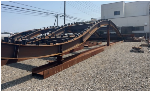
写真-5 屋根鉄骨仮組状況
