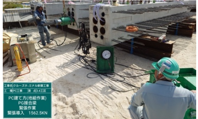
写真-12 PG梁の緊張状況
