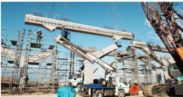
写真-11 PG梁の架設
