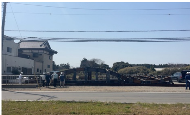
写真-6 屋根鉄骨部材ワンユニット
