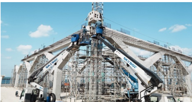
写真-12 コーナー部材の架設
