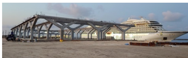
写真-4 PC部材が上がった現場2
