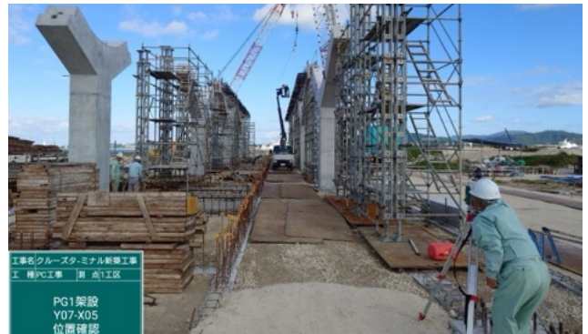
写真-13 測量状況1
