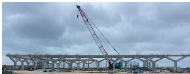
写真-3 PC部材が上がった現場1
