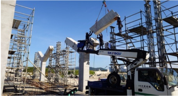
写真-9 PT梁の架設1
