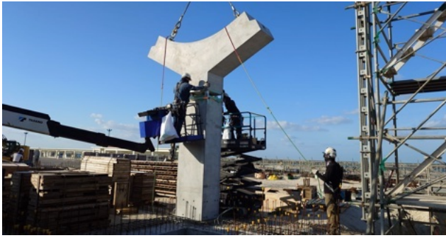
写真-8 YG柱の架設
