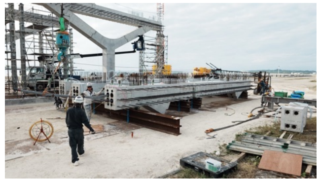
写真-7 PG1組立状況
