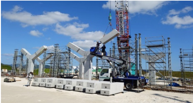
写真-10 PT梁の架設2
