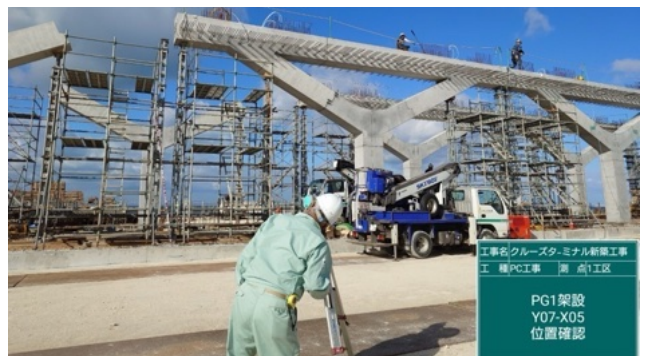
写真-14 測量状況2
