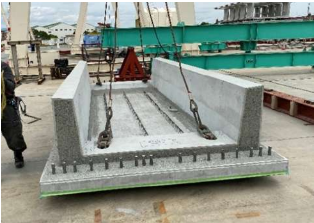
写真 - 1 4 PCa 屋根版の工場製作
