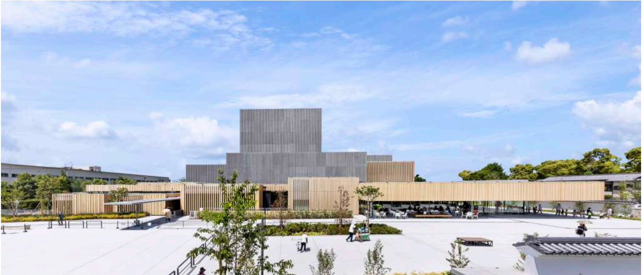
写真 - 1 建物外観（東側）
