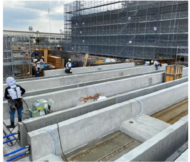
写真-12 配線配筋状況
