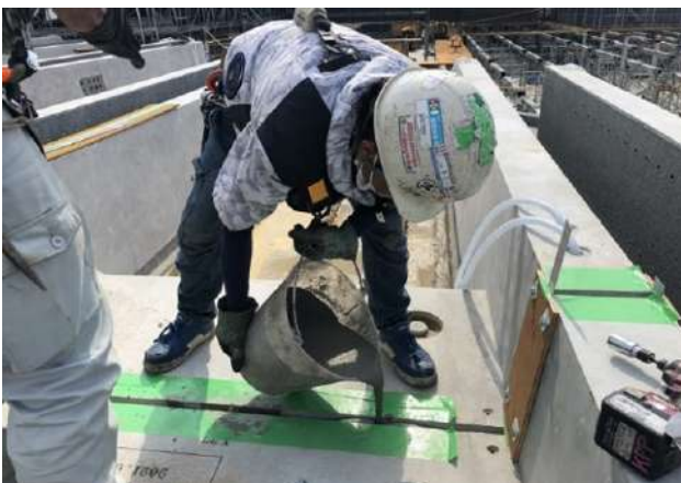
写真 - 1 6 部材圧着工法 目地打設状況
