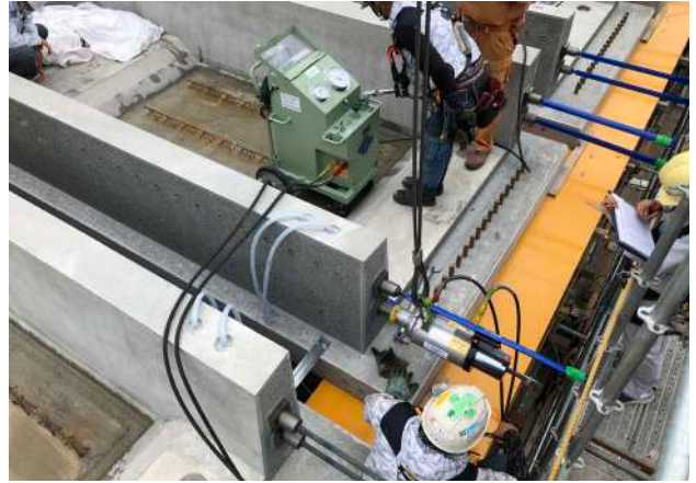
写真 - 1 7 部材圧着工法の現場緊張
