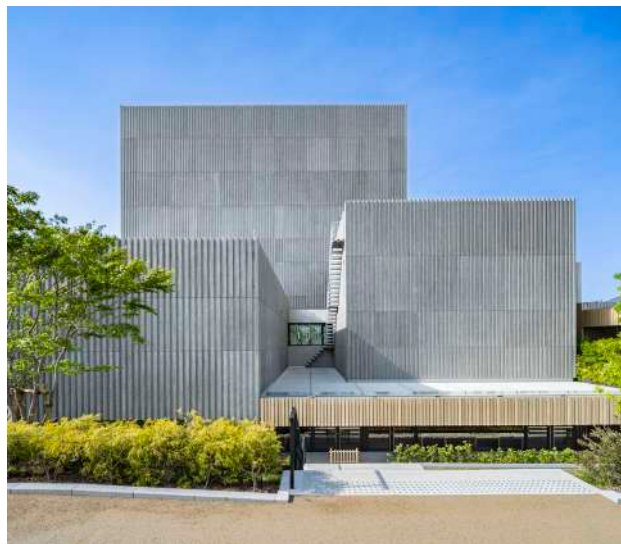
写真 - 8 外観写真 (南側)
