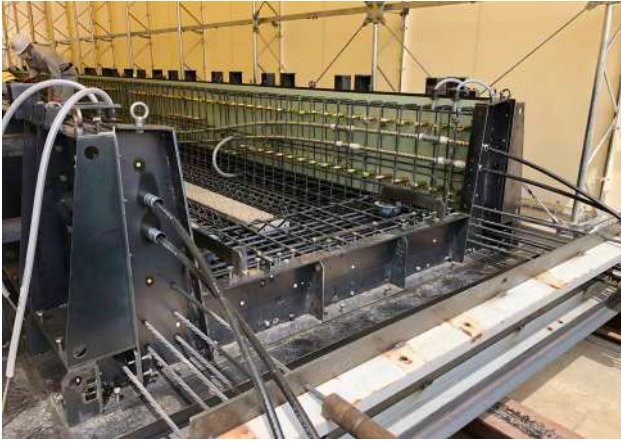
写真 - 1 3 工場緊張（プレテンション工法）
