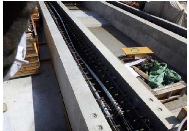
写真 - 1 8 VSL 工法の配線状況
