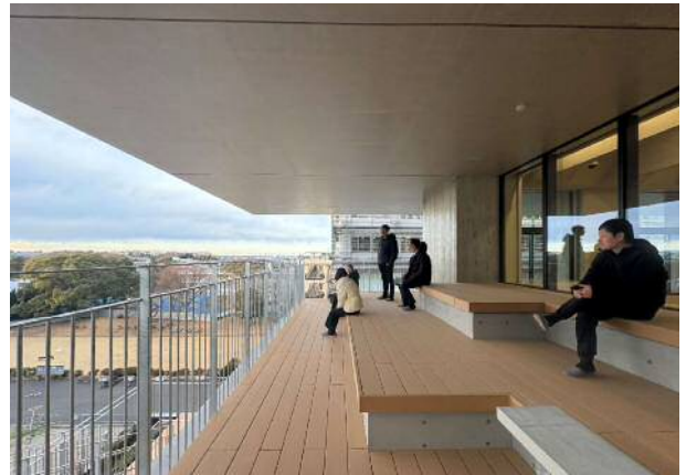
写真-4 外部バルコニー、打ち放しコンクリートの軒天
