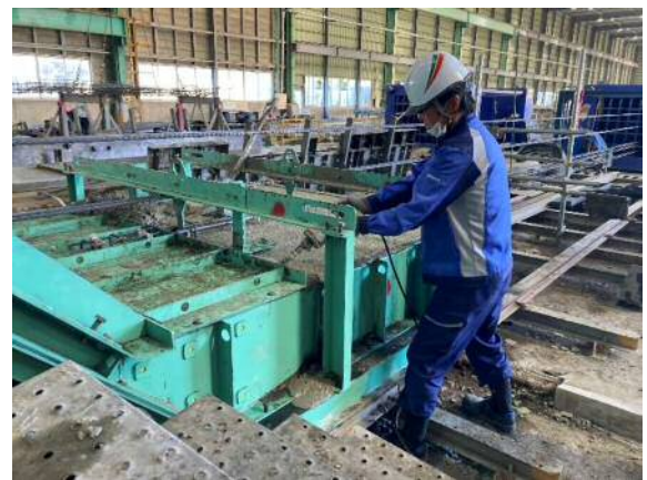
写真-10 コンクリート打設状況②
