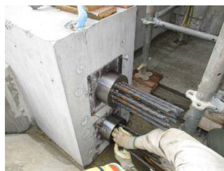
写真-1 6 ST4の圧着梁部の現場緊張
