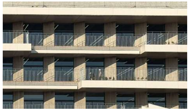
写真-3 南北面の五角形断面柱による日射遮蔽
