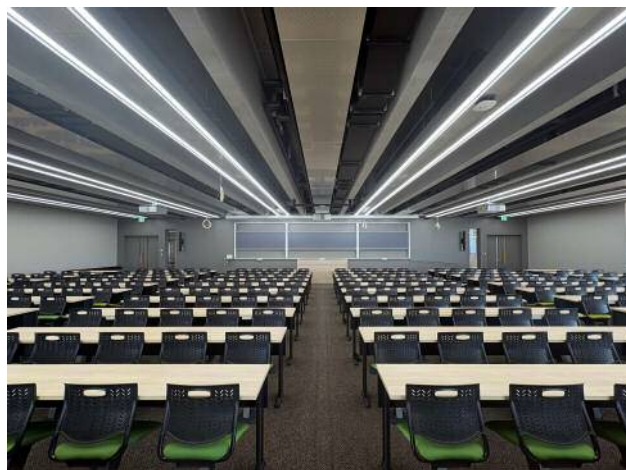
写真-6 図書館階のPCaPS床版 (ST2) の内観
