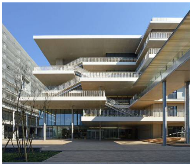
写真-1 建物外観
