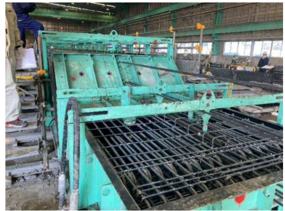
写真-8 ST1 配線配筋状況
