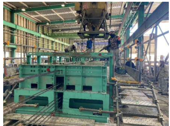
写真-9 コンクリート打設状況①
