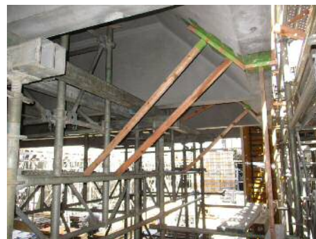
写真-1 5 ハンチ部のノ口止め処理
