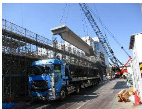
写真-1 2 PCa床版の現場楊重
