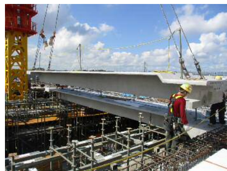
写真-1 3 PCa床版の架設
