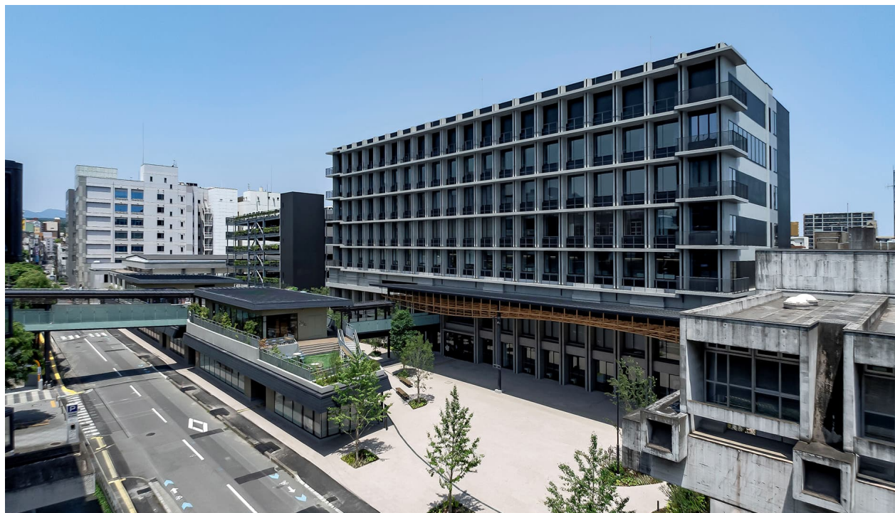
写真-1 意匠・構造・設備機能が一体となったファサード
