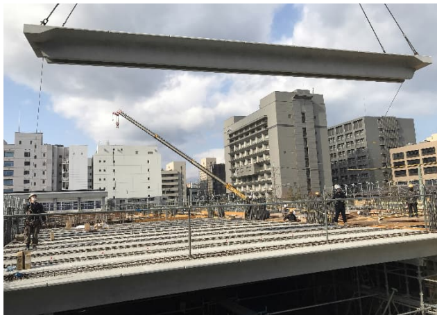
写真－8 PCaDT板架設状況（吊り上げ）
