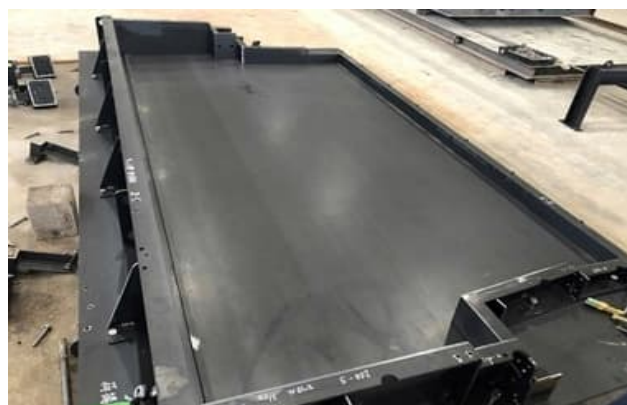
写真－７ PCa底板の鋼製型枠
