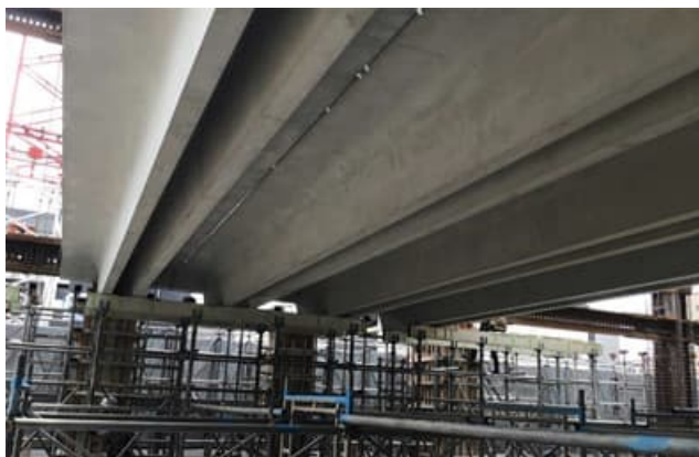
写真－9 PCaDT板設置状況
