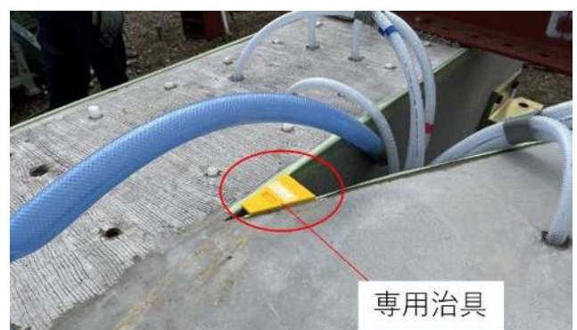
写真-4 柱交差部の治具使用状況
