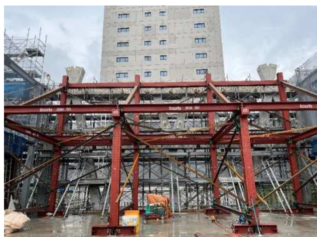
写真-6 仮設鉄骨構台
