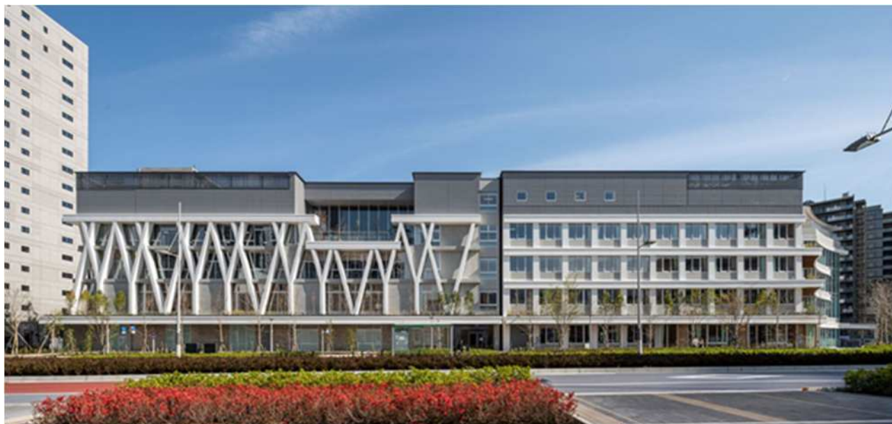
写真-1 北側外観
