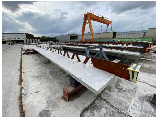
写真-7 脱型後フラットバー状況
