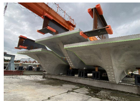
写真-6 脱型後端部リブ形状
