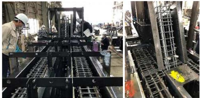
写真-10 斜め柱配筋状況
