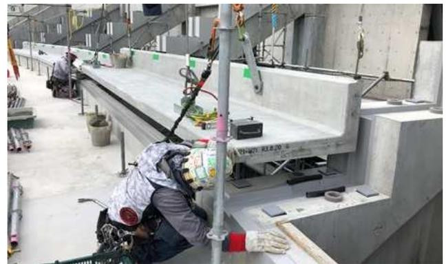
写真-21 PC段床版仮設・据付け状況
