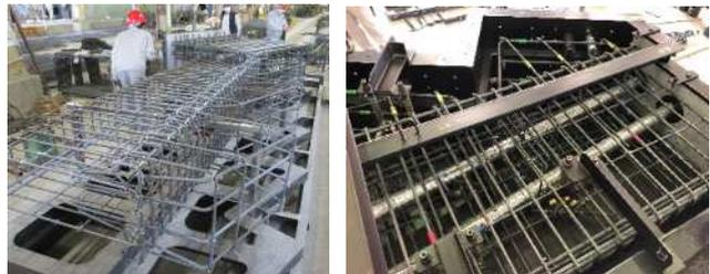
写真-12 段梁配筋状況
