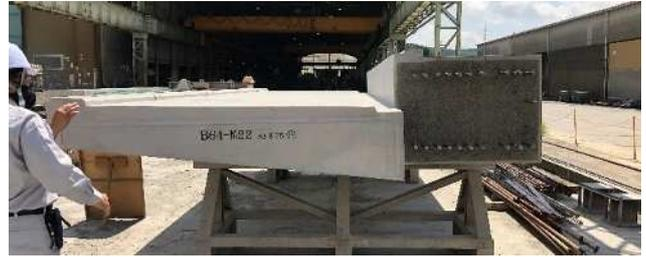
写真-20 床付き小梁架設状況
