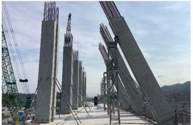
写真-16 バックスタンド斜め柱施工状況
