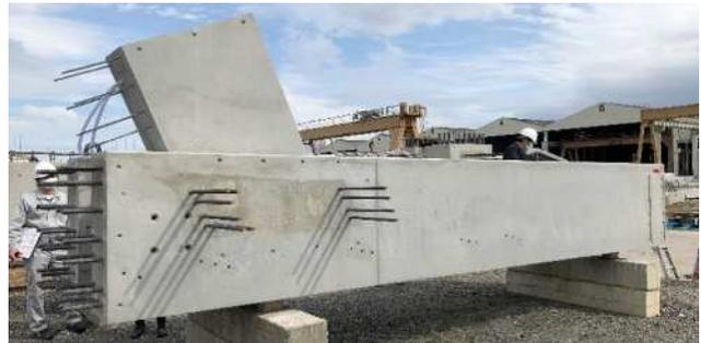
写真-11 斜め柱製作状況
