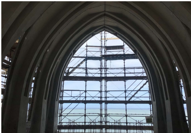
写真-14 全部材架設完了
