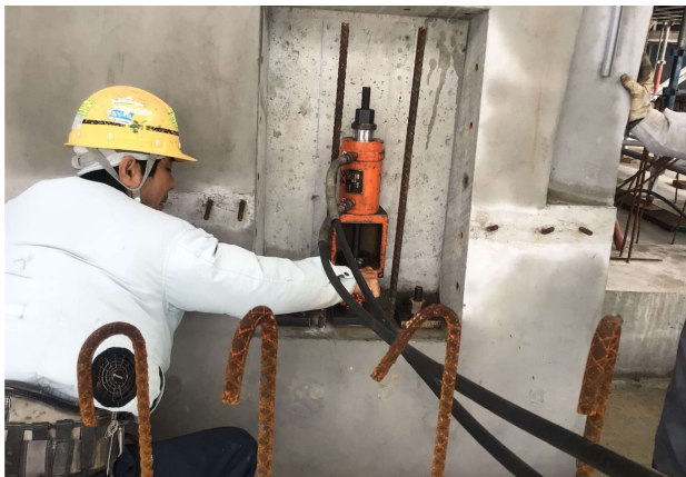
写真-15 柱脚部 PC 鋼棒緊張状況
