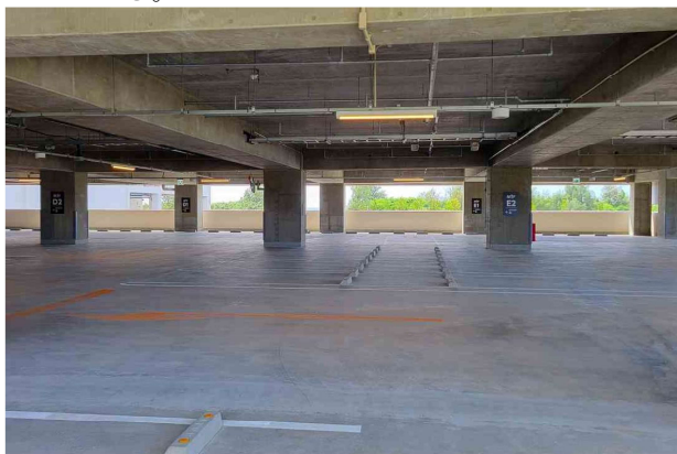
写真-9 駐車場内部写真
