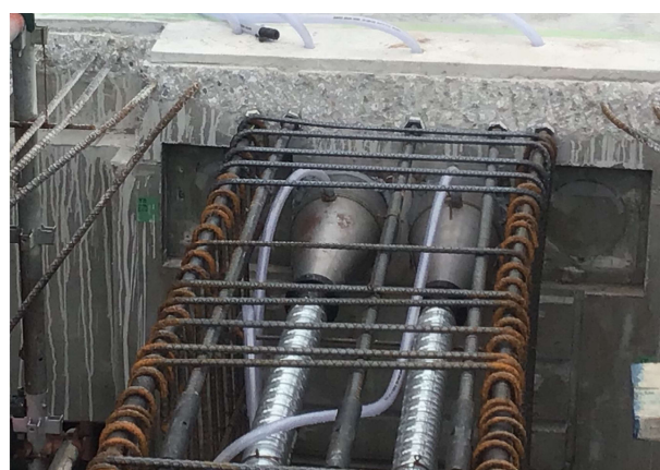
写真-11 PC 鋼材接続具連結状況
