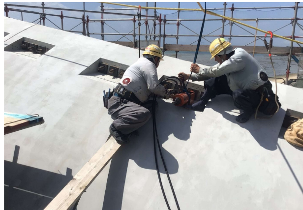
写真-16 頂部 PC 鋼棒緊張状況
