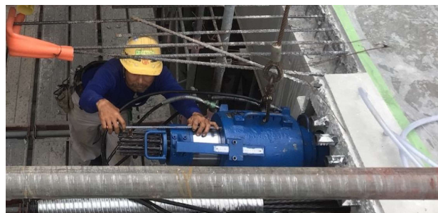
写真-10 1工区 PC 鋼材緊張状況
