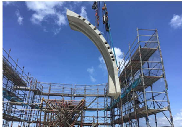
写真-13 架設状況
