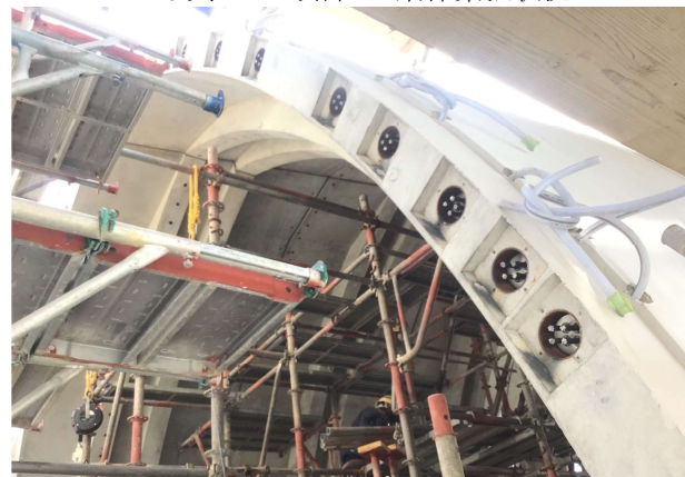
写真-17 部材相互一体化用 PC 鋼より線緊張完了
