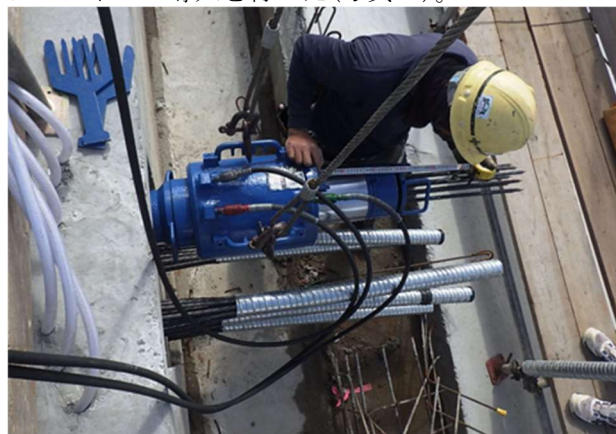
写真-8 緊張作業状況
