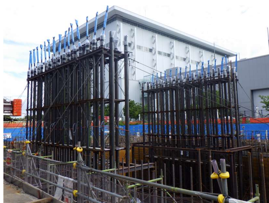
(a) シース菅の仮設フレーム
