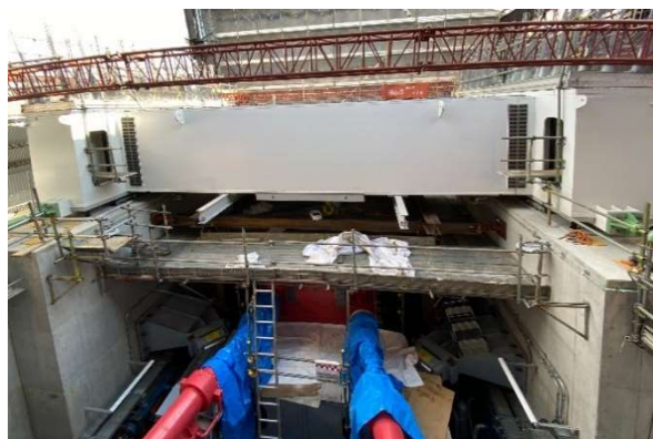
(b) 反力梁の弾性支承上への設置
