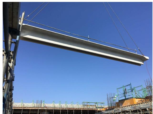
写真-12 DT 版架設状況 (吊り上げ)
