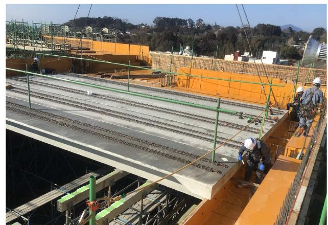
写真-13 DT 版架設状況 (設置)
