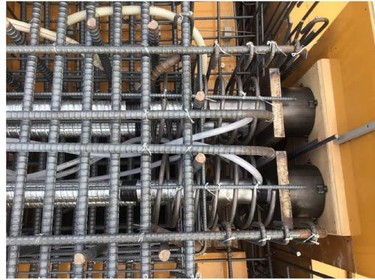
写真-15 柱頭付近の定着具納まり状況
