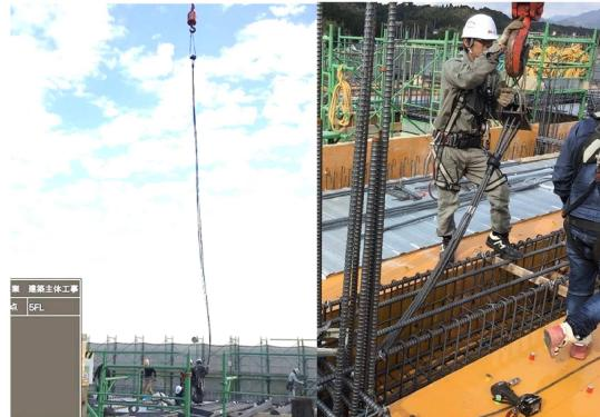
写真-16 クレーンを使用した配線作業
