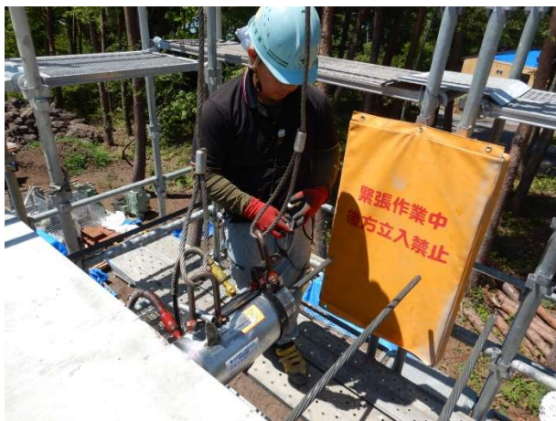
写真10 緊張状況(通常ジャッキ)
