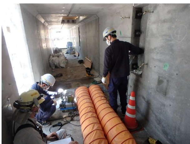
写真11 緊張状況(ボルトテンショナー)
