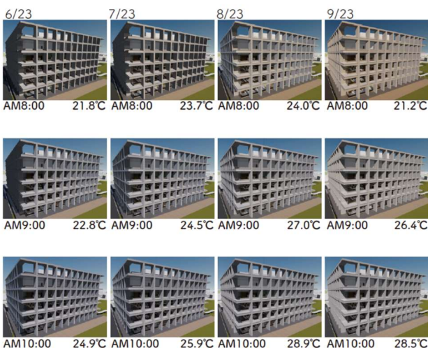
図-11 日射制御に貢献する外周の扁平梁
