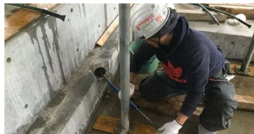
写真-9 ジャッキスペースの確保
