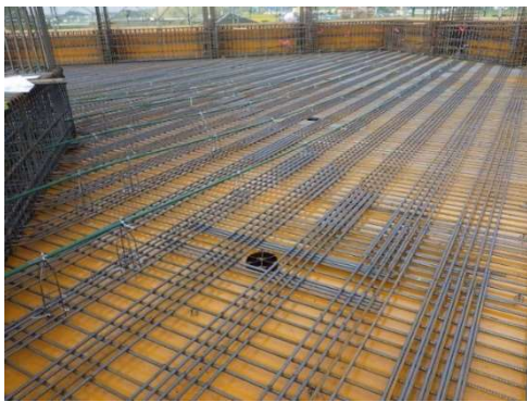
写真-11 アンボンドPCケーブルの配線状況
