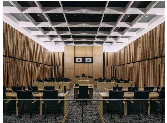
写真-4 鉄骨格子フレームの議場屋根
