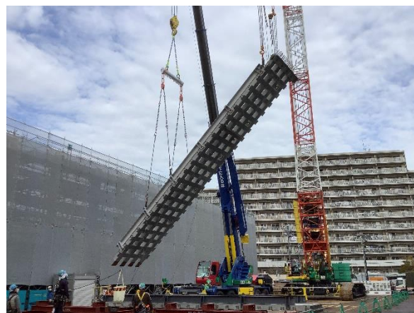
写真-11 格子壁建方状況
