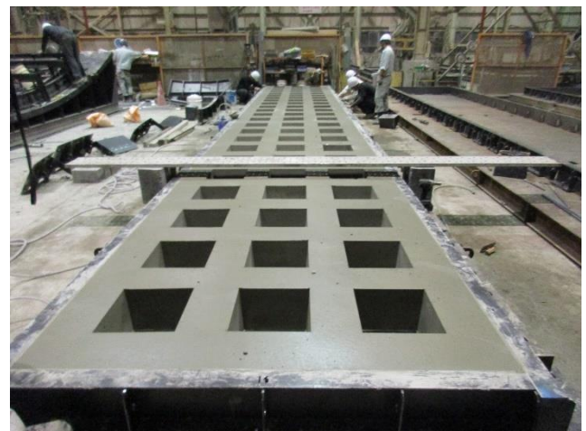
写真-17 コテ仕上げ完了
