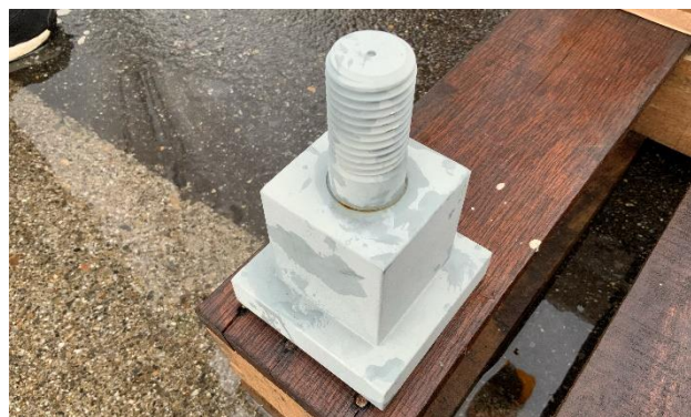
写真-8 SPC 格子壁 柱頭接合部 角ボルト
