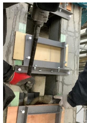
写真-14 モルタル打込み
