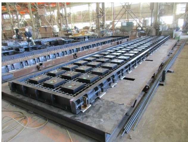
写真-16 配筋・型枠セット状況
