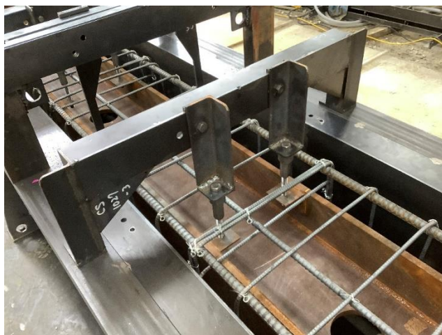
写真-19 製作状況
