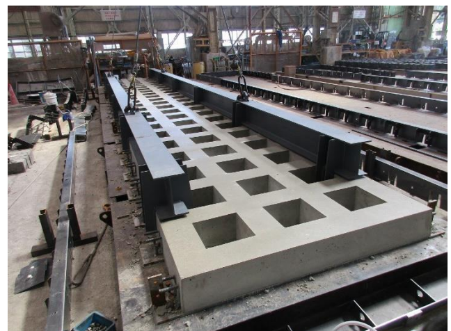
写真-18 脱型状況
