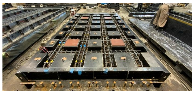
写真-9 試験体製作状況
