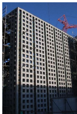
写真-13 格子壁全景
