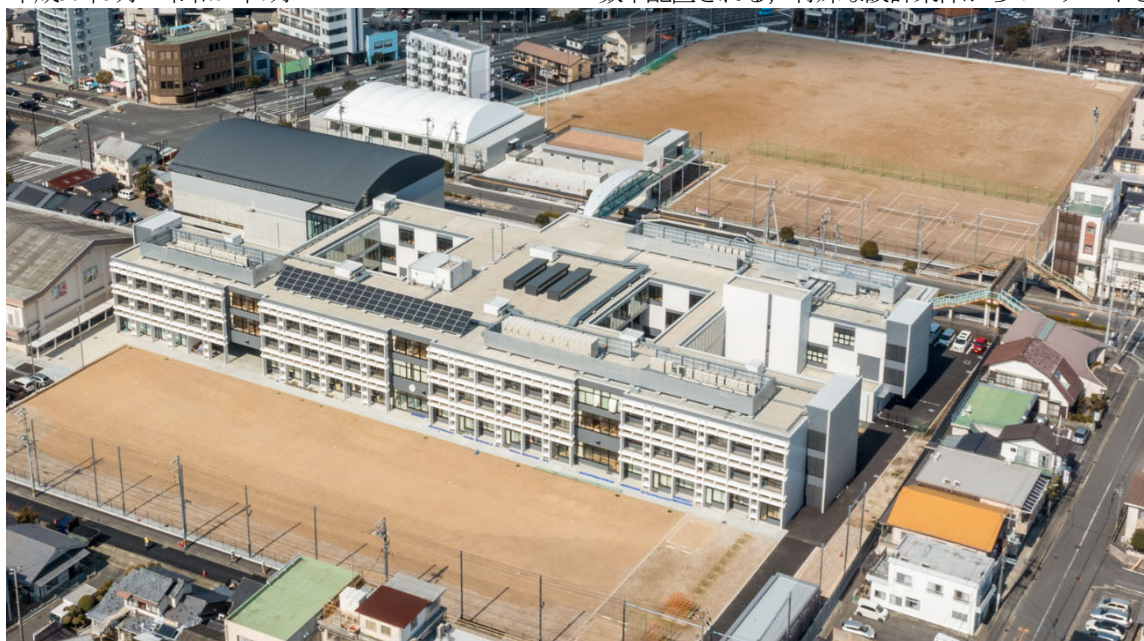
写真-1 建物全景
