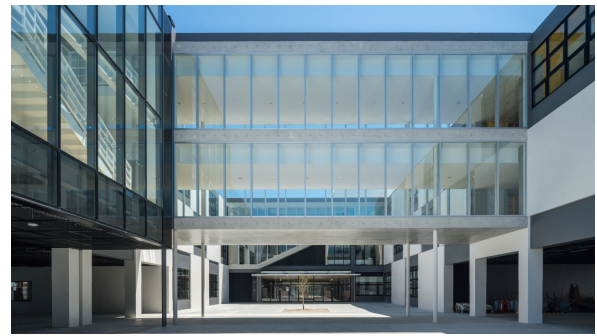
写真-6 PRCスラブの渡り廊下
