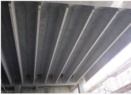
写真-5 ST床版架設状況, 断面図
