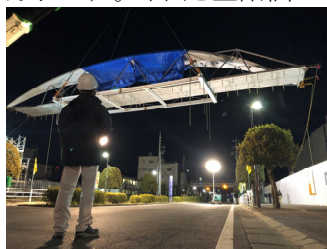
写真-16 連絡橋架設
