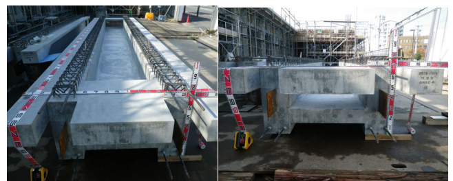
写真-4 床下配管スペースつきDT版
