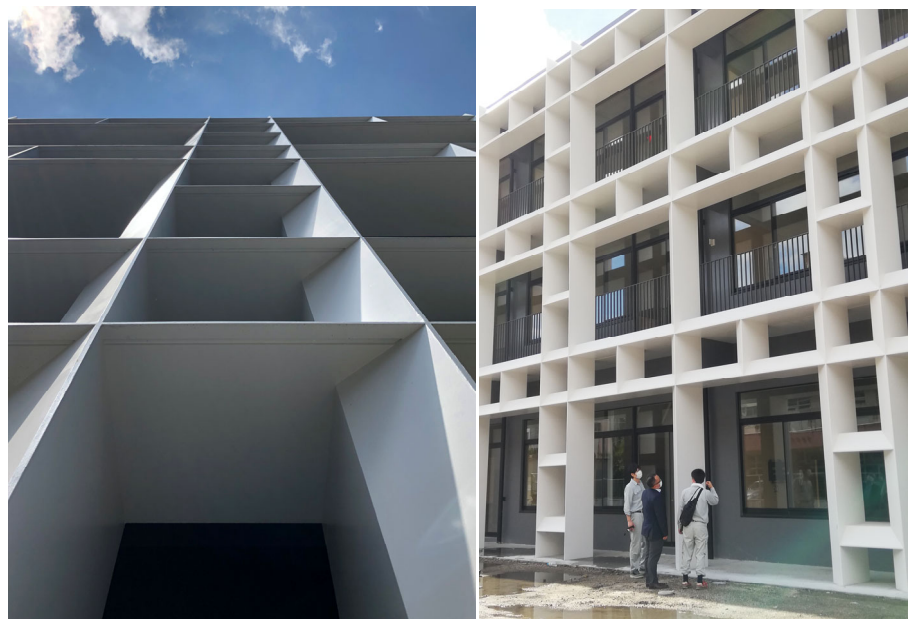
写真-14 建て方後のフィーレンディール架構
