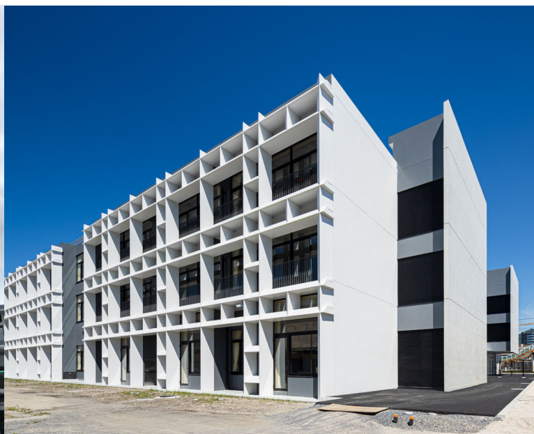
写真-18 校舎南面外観
