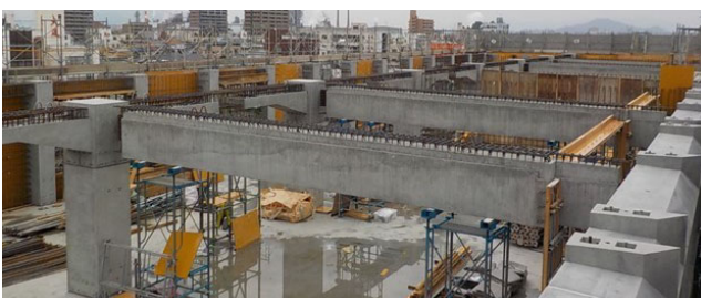
写真-3 端部をガセット接合としたPCaPC大梁
