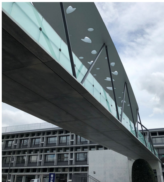
写真-17 連絡橋見上げ
