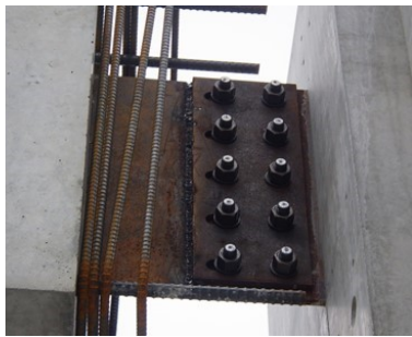
写真-15 ガセットプレート接合
