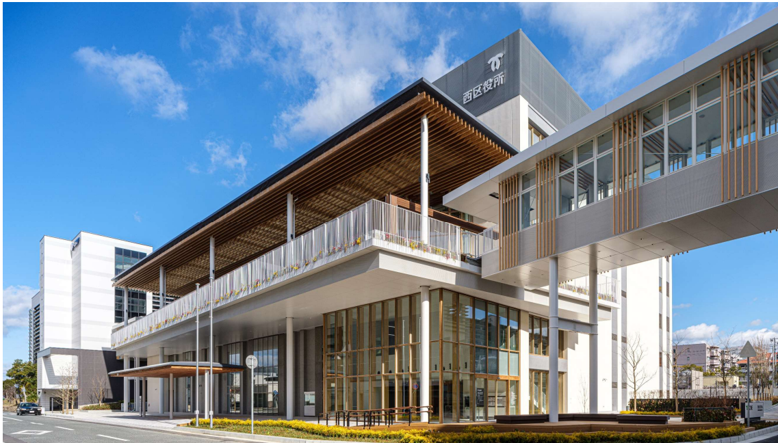
写真－１ 建物全景
