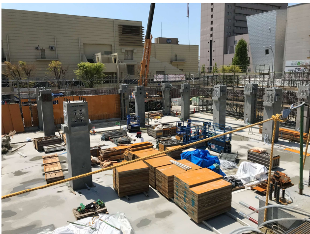
写真－7 PC柱架設状況
