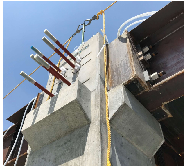
写真－9 柱梁接合部の状況
