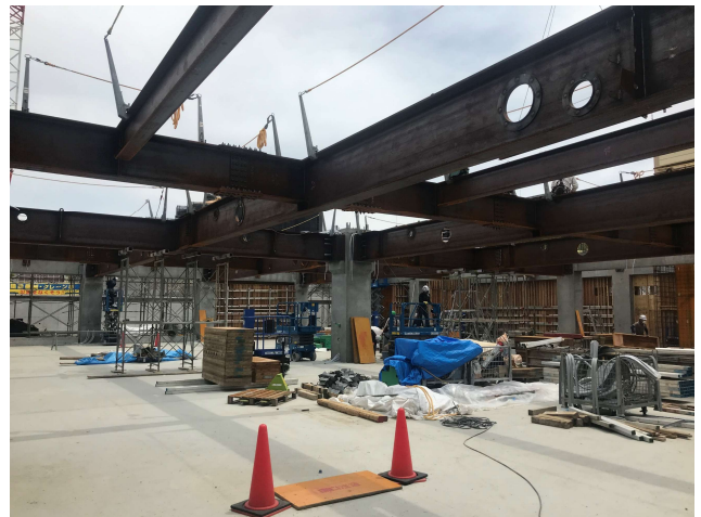
写真－8 PC-S梁架設状況
