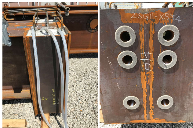
写真-5 PC-S梁端部
