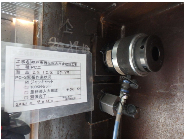
写真－11 PC-S梁の緊張
