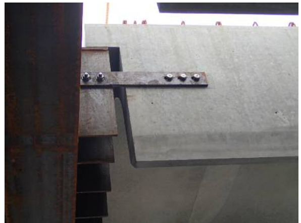
写真-5 床版端部状況
