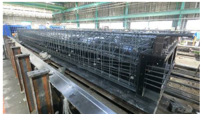
写真-8 配筋状況
