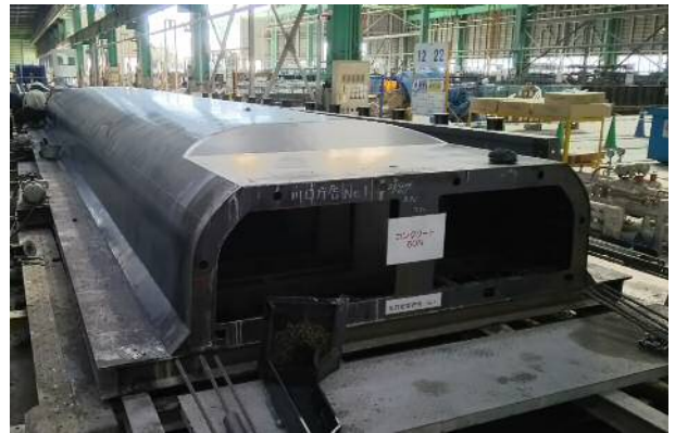
写真-7 型枠の状況 (PS1)
