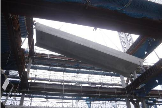
写真-10 PC床版の架設状況
