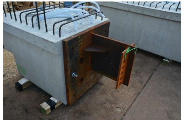
写真-8 片持ち梁 PCa 部材
