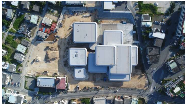
写真-4 重なる屋根（施工中）
