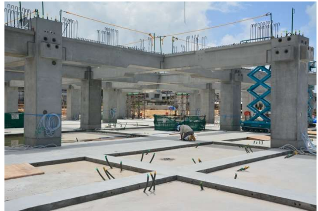
写真-9 視線が抜ける空間（12mグリッド）
