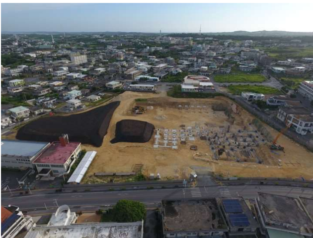
写真-3 既設レベルに合わせた基礎
