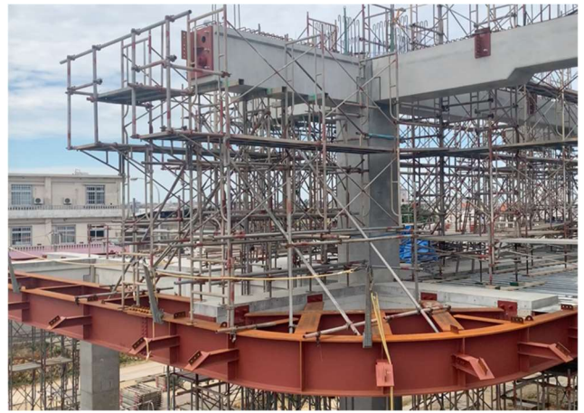
写真-7 片持ち梁の架設状況
