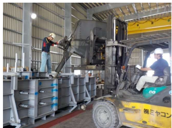
写真-15 打設状況
