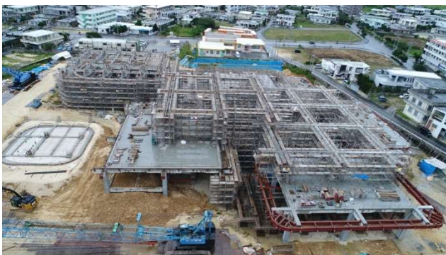
写真-12 組み上がった現場
