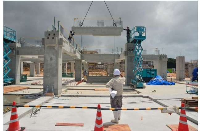
写真-16 梁の架設 (6m スパン)
