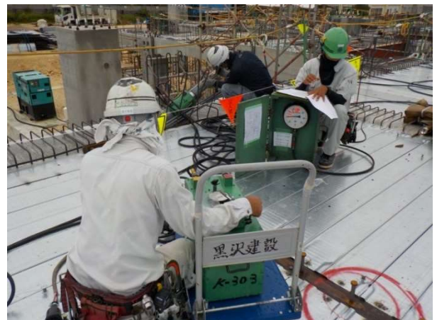
写真-17 緊張状況
