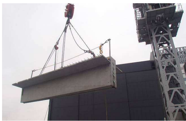
写真-9 PCa部材搬入、吊り上げおよび架設状況
