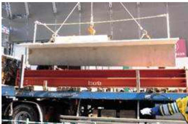
写真-9 PCa部材搬入、吊り上げおよび架設状況
