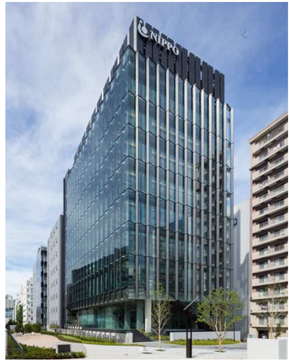
写真-4 北東側ダブルスキン外観
