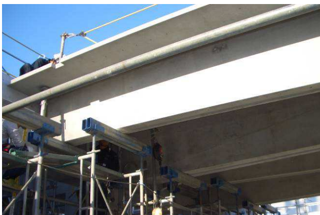
写真-10 PCa部材の架設完了状況
