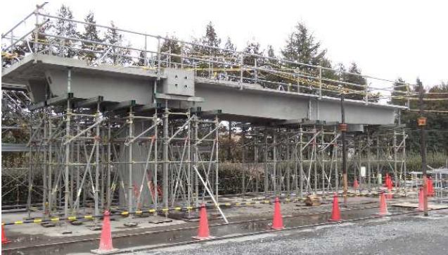
写真-7 モックアップによる部材形状の確認
