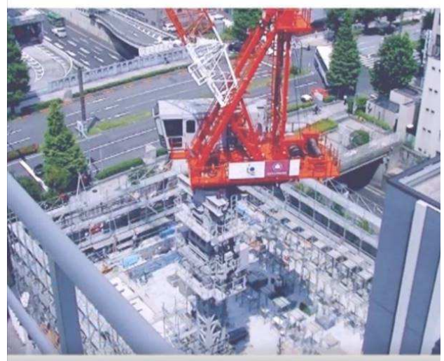
写真-5 狭小敷地における架設状況
