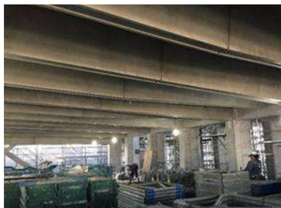
写真-10 PCa部材の架設完了状況
