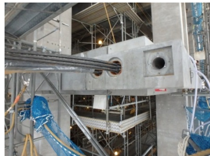
写真一 9 化粧リブ調整ケーブル 除荷後状況
