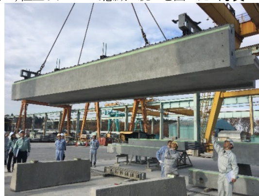
写真-6 スパン梁製品検査状況
