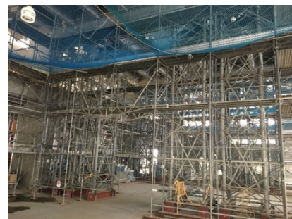
写真一 10 講堂上部大梁 オールステージ支保工
