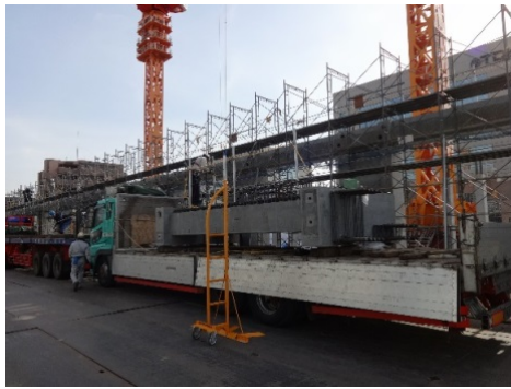
写真-7 桁梁搬入写真
