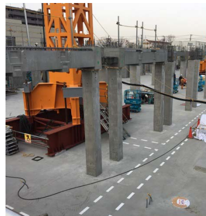
写真-8 桁梁の架設状況
