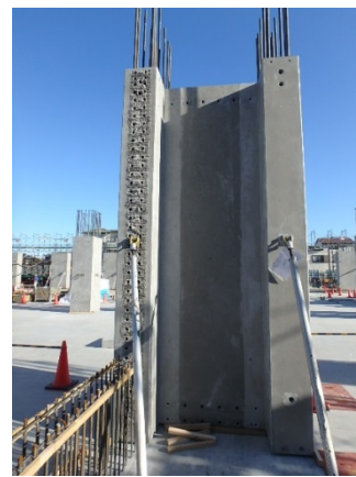
写真-5 H型柱建て方状況 (撮影側がY2-3間)
