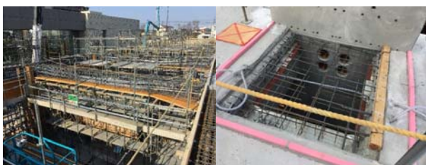
写真一 1 1 在来工区状況
