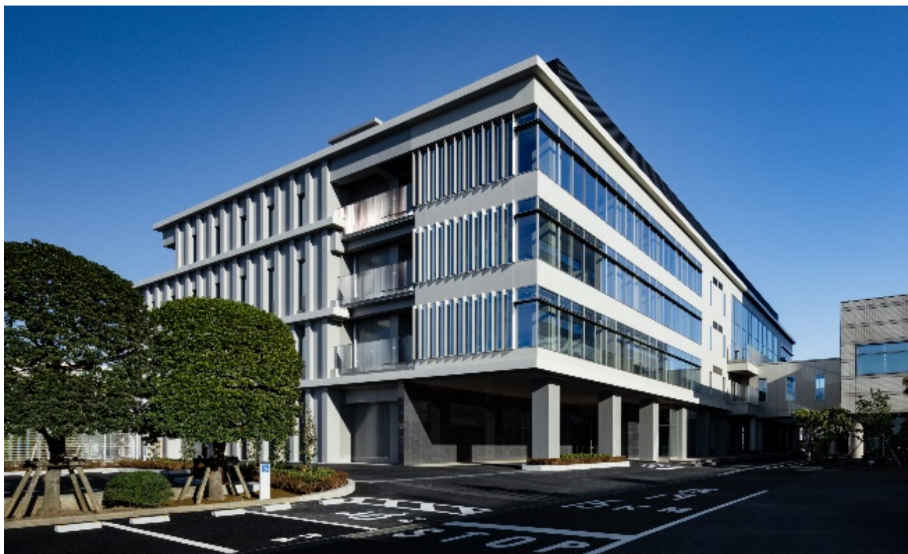
写真-1 エントランス外観
