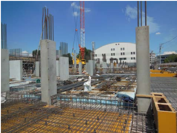
写真-12 内部柱建方状況
