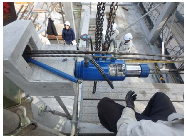
写真-16 緊張作業
