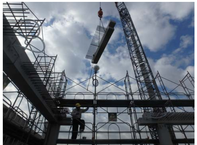
写真-15 環境テラス架設状況
