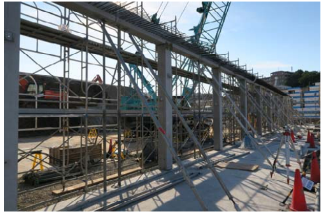
写真-14 環境テラス施工状況
