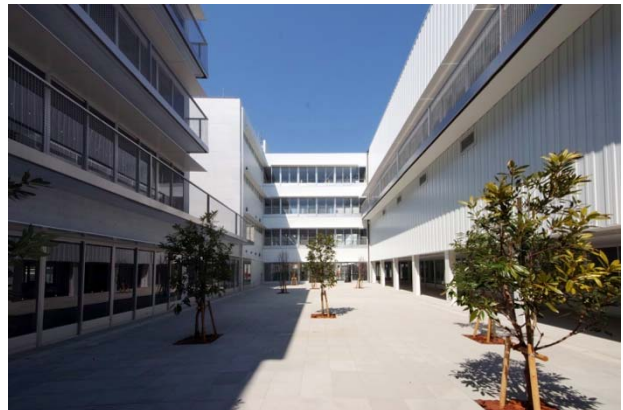
写真-3 光庭 (写真：山本理顕設計工場)
