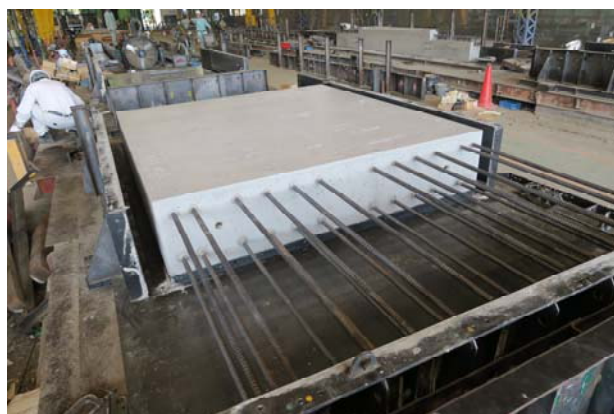
写真-11 内部柱製作状況
