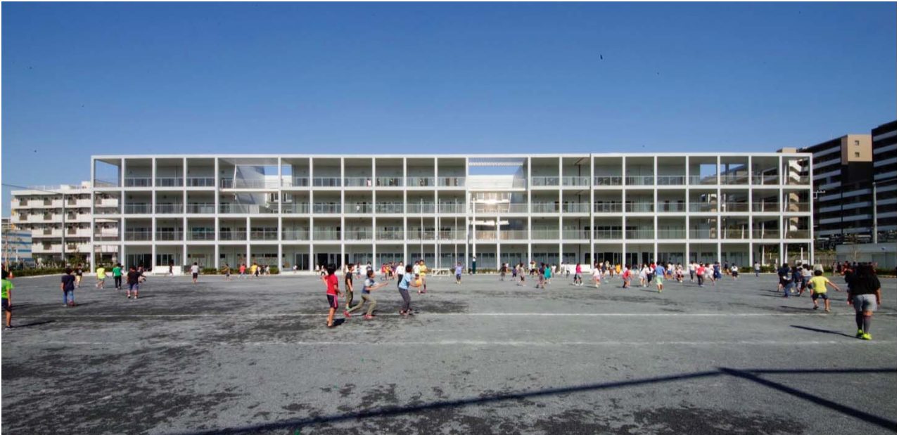
写真-1 横浜市立子安小学校 外観 (写真：山本理顕設計工場)
