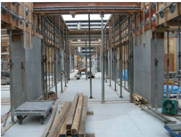
写真-13 梁型枠施工状況
