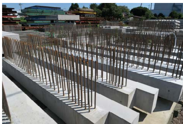
写真-10 環境テラス梁製作状況
