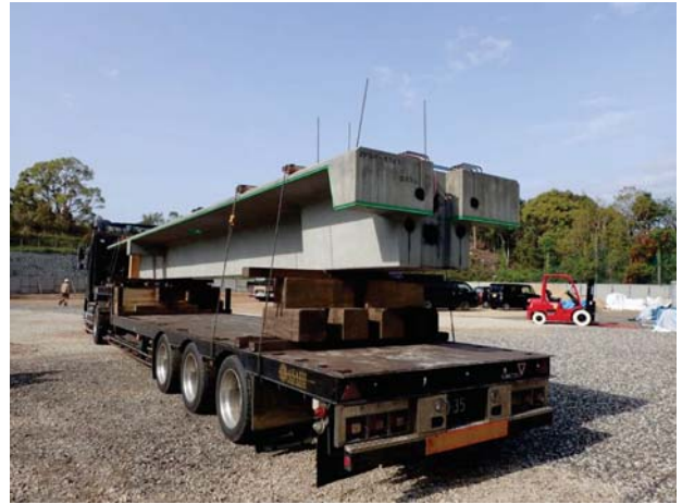
全長18m武道場PC床板の一部(2mx12m)
