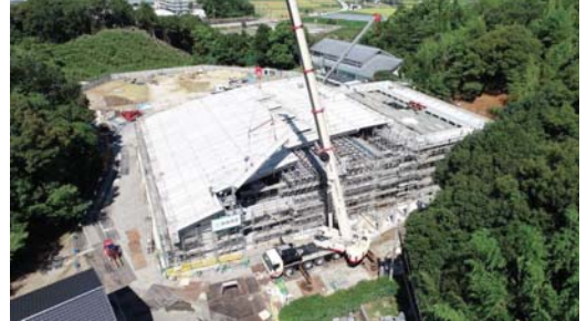
施工中ドローン空撮
