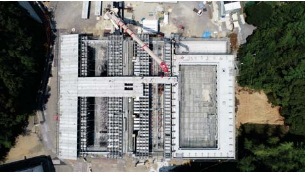
屋内プール屋根PC板建方(4分割)
