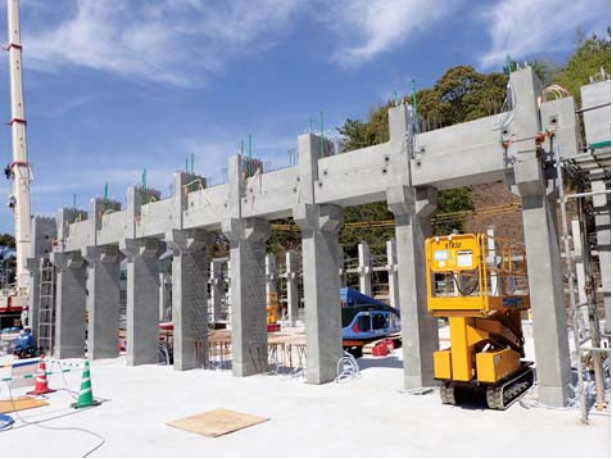
武道場柱と梁(2F)の建方
