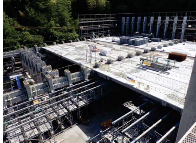
12mホールPC床板(手前)と18m武道場床板(奥)の建方
