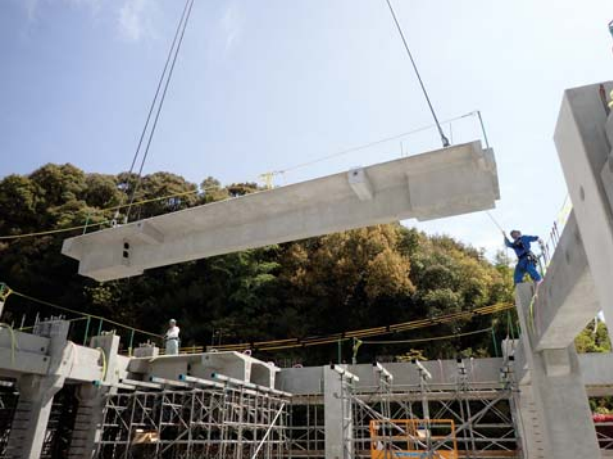
ホールPC 床板の建方(2mx12m)
