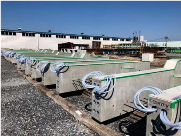
武道場柱の製作
