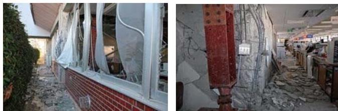
※須賀川市旧庁舎被害状況：主体構造部に甚大な被害を受け使用不能となり解体
