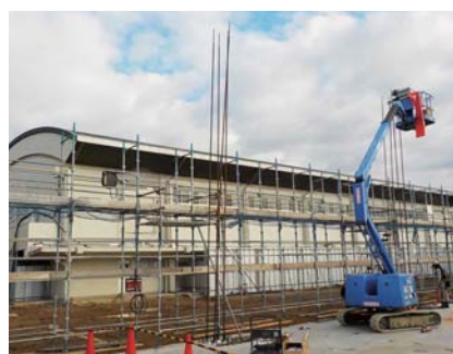
PCa 柱鋼棒設置
