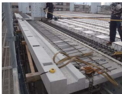
HPC 片持ち床版 写真-10 施工状況
