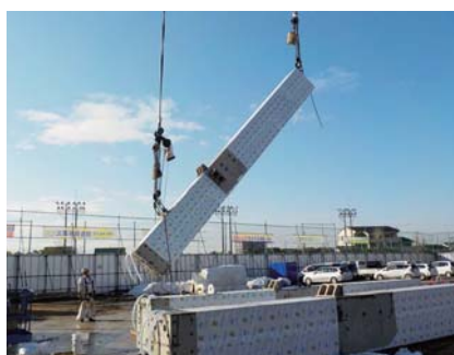
PCa 柱立て起こし
