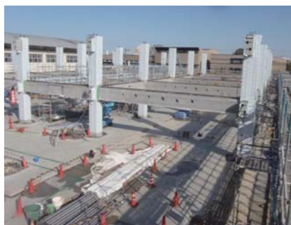
I 工区全景
