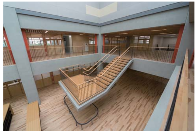
写真-7 愛知県産材の木製踏板
