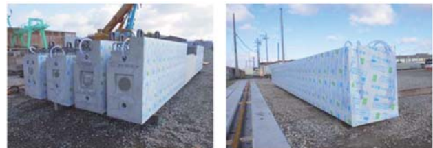
写真-9 PCa 部材のストックの状況（保水養生テープ）
