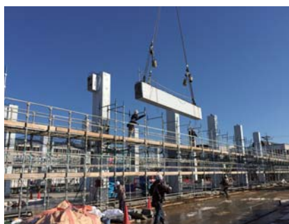
PCa 大梁架設
