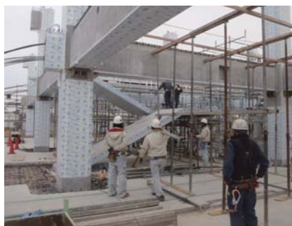
PCa 階段架設
