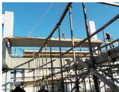
HPC 床版架設
