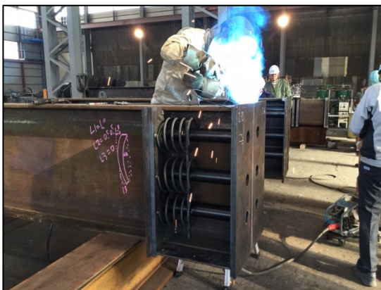
写真 1 溶接施工試験
