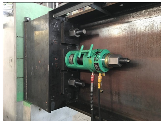
写真 4 PC 鋼棒への PS 導入
