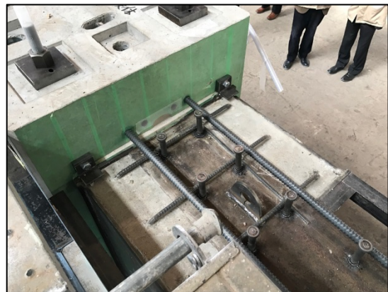
写真 3 組立施工試験（PCS 端部）
