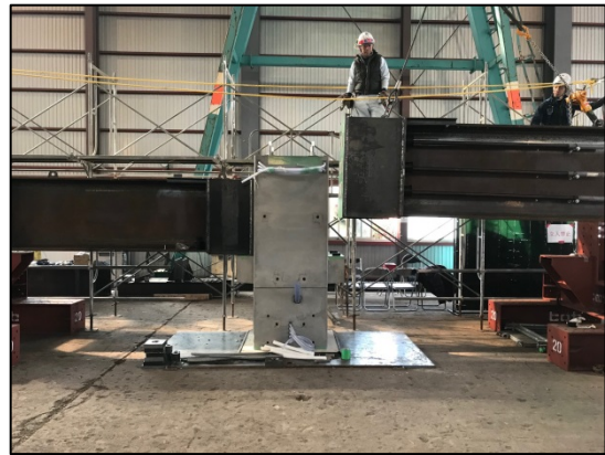
写真 2 組立施工試験（全体）
