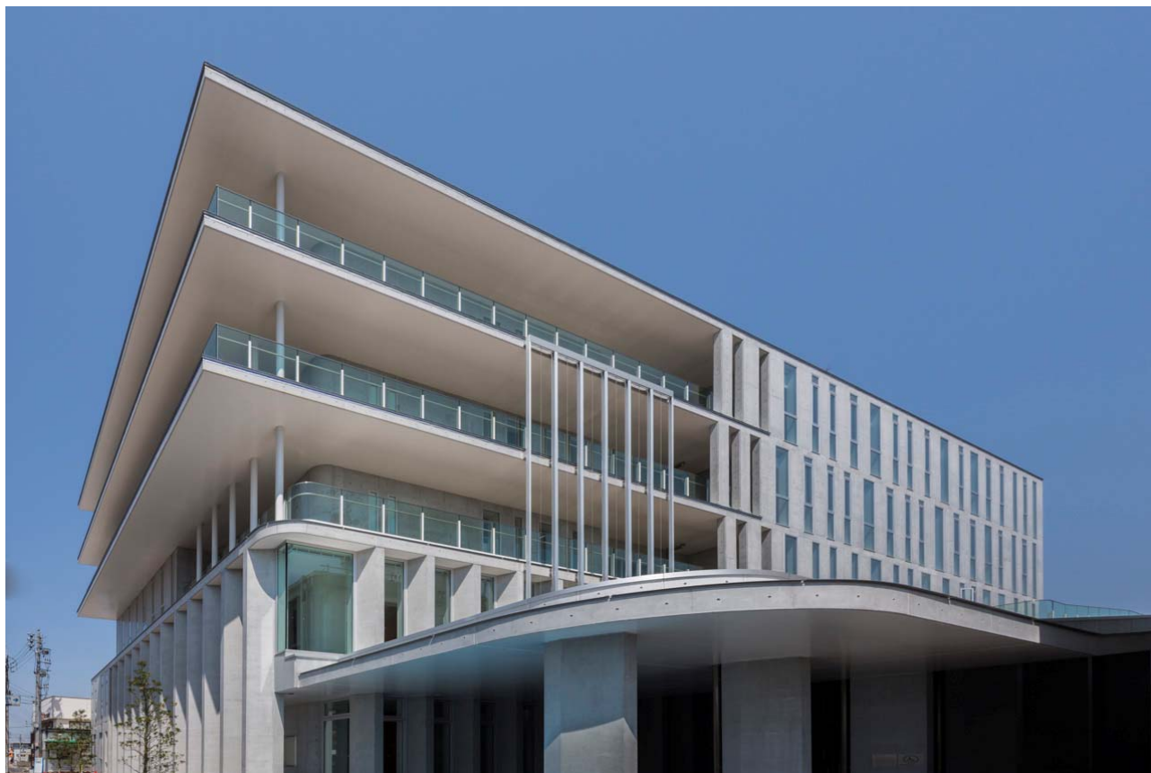
写真-1 建物外観
