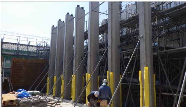
写真-11 PCa柱 設置状況
