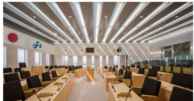
写真-5 SU 版を用いた天井
