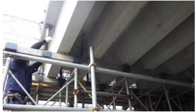
写真-13 ST版 設置状況
