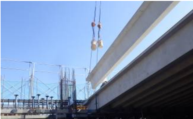
写真-12 ST版 架設状況
