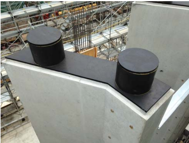
写真-7 柱頭部 現場状況
