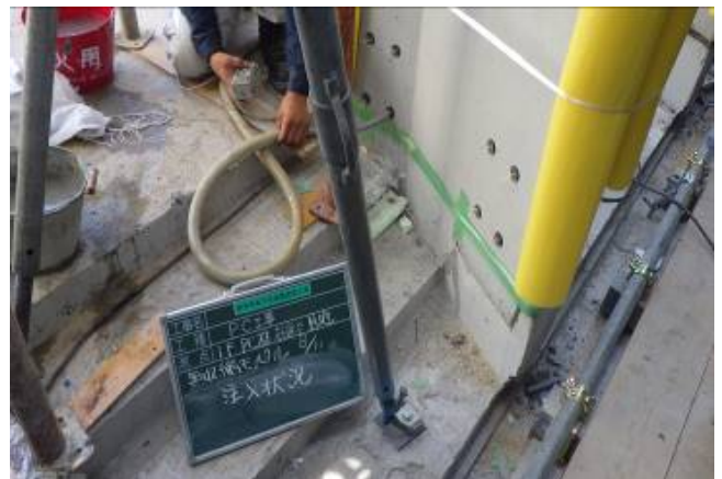
写真-6 柱脚部 施工状況
