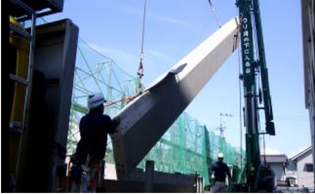
写真-10 PCa柱 建起こし
