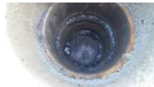
パイプアンカー接合
