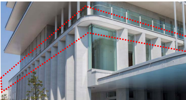
写真-8 PCa柱とスラブの納まり
