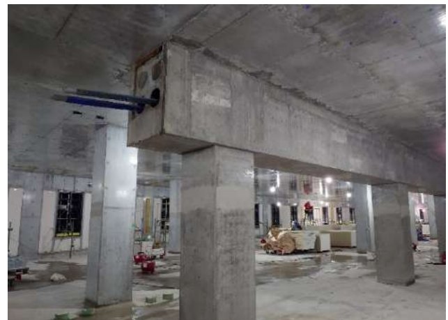
写真5 地上4階PC梁緊張後(下部2本未緊張)の様子
