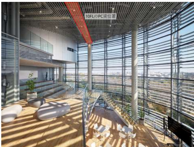
写真 8 共創スペース及び 10 階 PC 梁の位置
