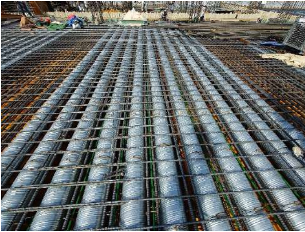
写真3 アンボンドPCボイドスラブの施工状況
