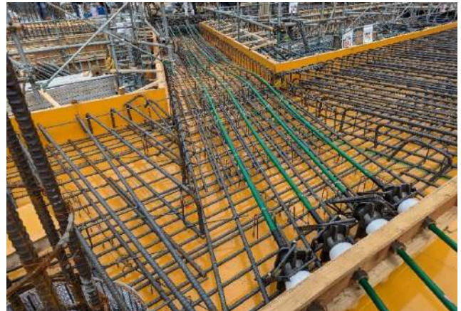
写真10 渡り廊下のPC鋼材配線状況
