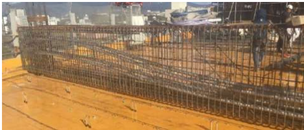
写真 7 10 階 PC 梁の PC 鋼材配線状況
