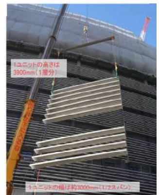
図4 アルミルーバー架台ディテールおよびユニット施工状況
