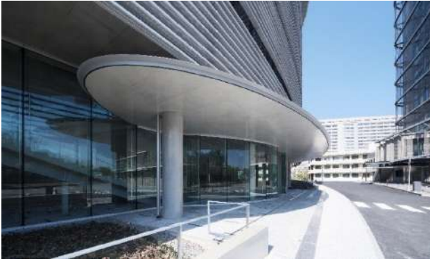
写真9 エントランス庇
