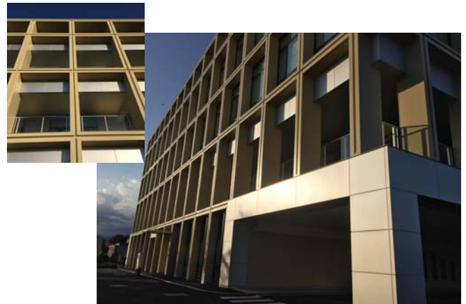
写真-10 建物全景（南面）
