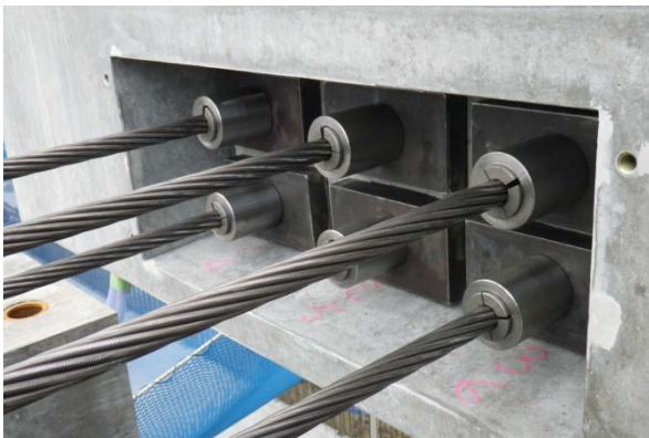
写真-2 シングルストランド定着具納まり状況
