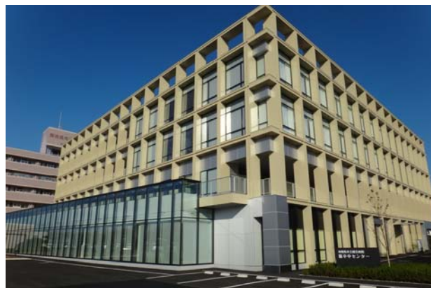
写真-1 建物外観（南西面）
