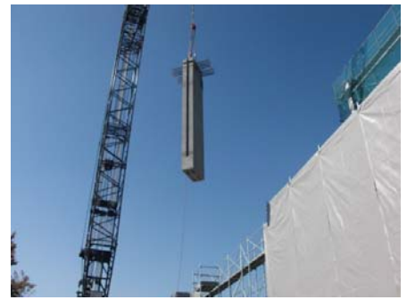
写真-4 PCaRC柱仮置き、建て起こしおよび吊り上げ状況
