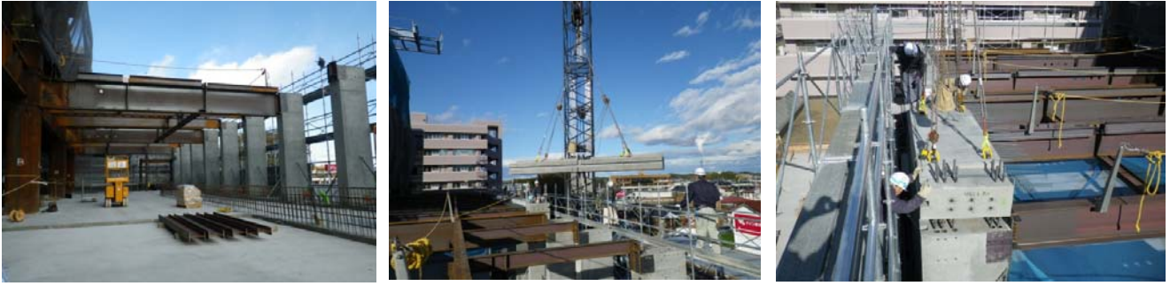
写真-6 PC a PC梁の架設状況
