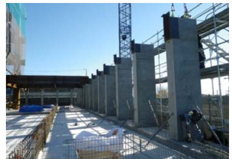
写真-4 PCaRC柱仮置き、建て起こしおよび吊り上げ状況
