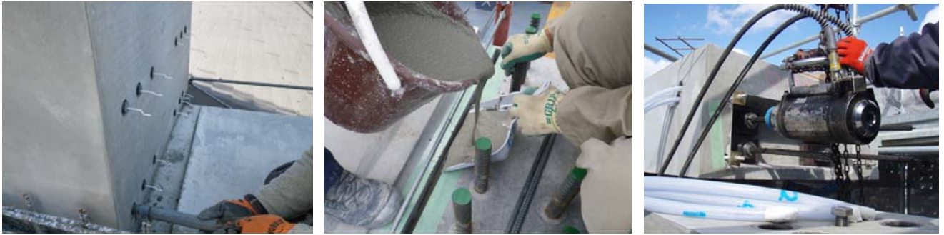
写真-7 PC a RC柱・PC a PC梁目地注入およびPC緊張状況
