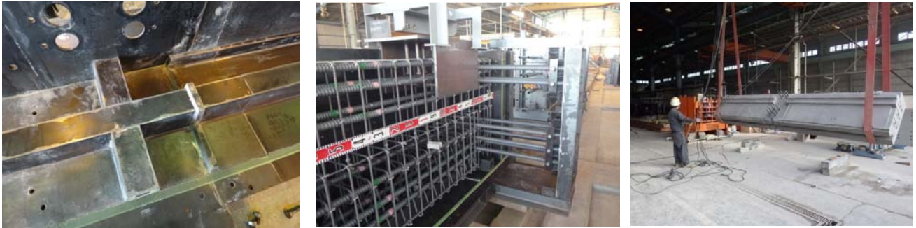
写真-3 PCa部材の製作状況
