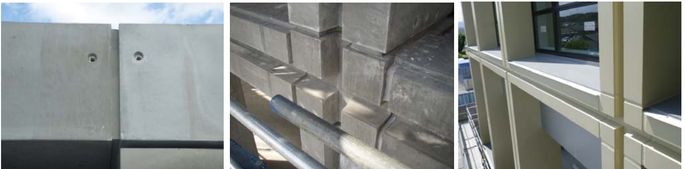
写真-8 PC a 部材仕上状況
