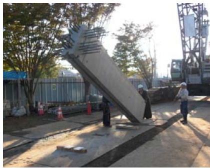
写真-4 PCaRC柱仮置き、建て起こしおよび吊り上げ状況
