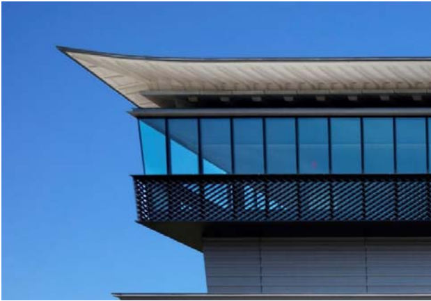
写真-8 飛燕垂木と反りを持つ屋根
