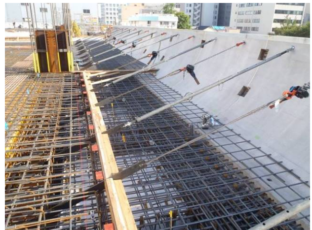
写真-21 PCaバルコニー版 架設状況
