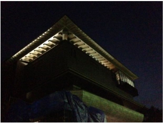
写真-9 PCaPCの軒先のライトアップ
