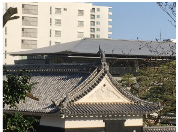
写真-12 追手門の屋根とPCaPC寄棟屋根の重なり
