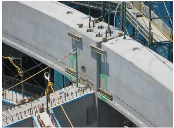
写真-8 転倒防止仮設留め金物（金物撤去後）
