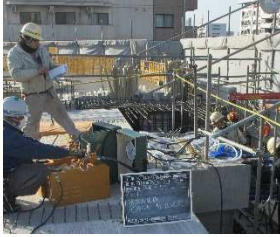
写真-8 緊張状況
