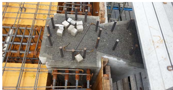
写真-3 機械式継手
