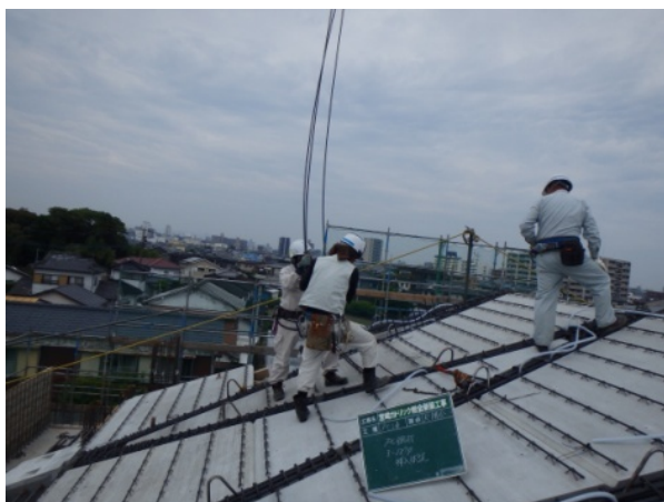
写真-10 PC 鋼材挿入状況
