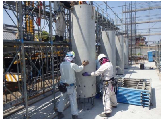
写真-6 丸柱架設状況
