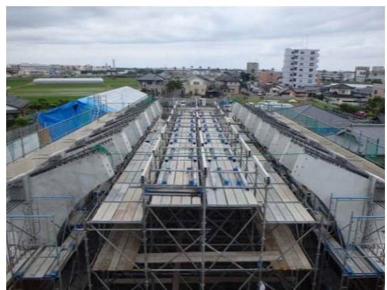
写真-7 V 梁架設完了
