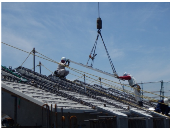
写真-9 PC 床版架設状況
