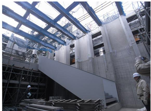
写真-23 鉄骨梁建方状況(3)
