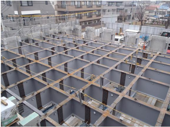
写真-24 鉄骨梁建方状況(4)
