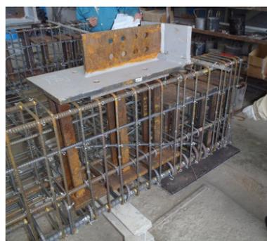
写真-10 鉄骨ガセットプレート部配筋状況
