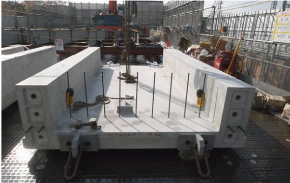
写真-11 PCaPC リブ付壁建方状況（1）
