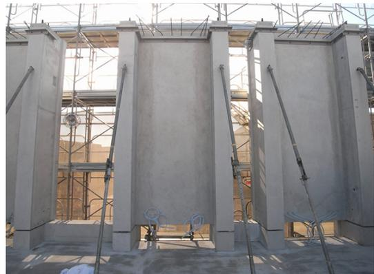
写真-17 PCaPC リブ付壁設置状況（室内側）
