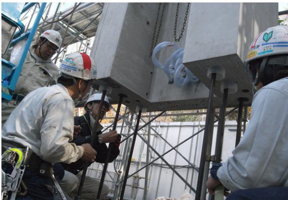
写真-13 PCaPC リブ付壁建方状況（3）
