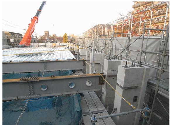
写真-22 鉄骨梁建方状況(2)
