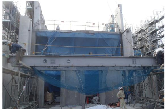
写真-21 鉄骨梁建方状況(1)
