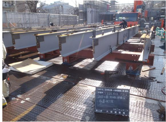
写真-20 鉄骨梁地組み状況
