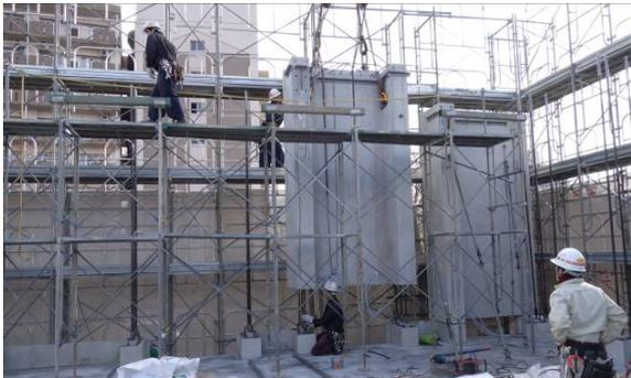
写真-12 PCaPC リブ付壁建方状況（2）
