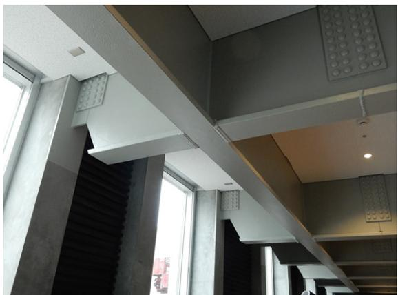
写真-26 PCaPC リブ付壁-鉄骨梁 接合部
