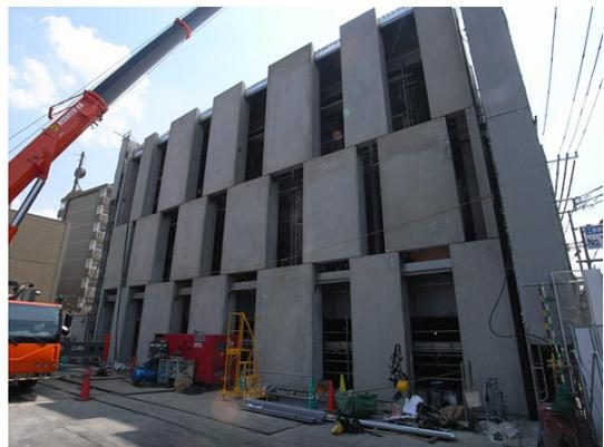
写真-16 PCaPC リブ付壁建方状況（6）
