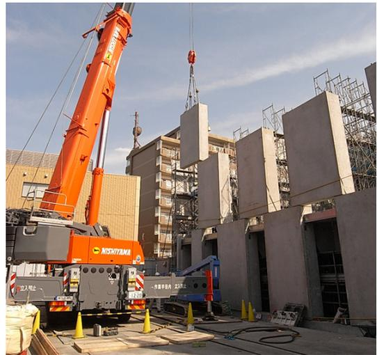
写真-15 PCaPC リブ付壁建方状況（5）
