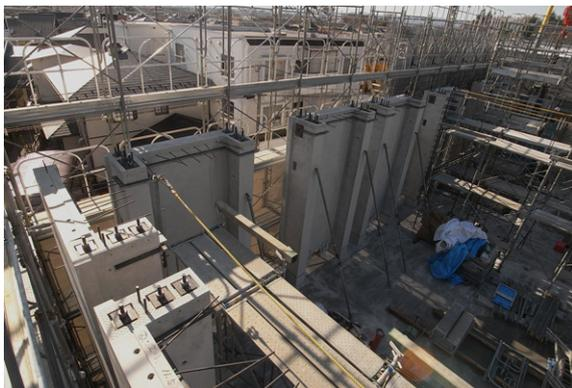
写真-14 PCaPC リブ付壁建方状況（4）
