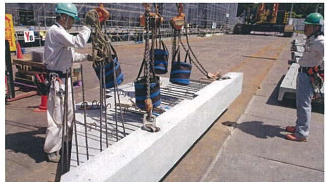
写真-7 隅角部バルコニーの揚重
