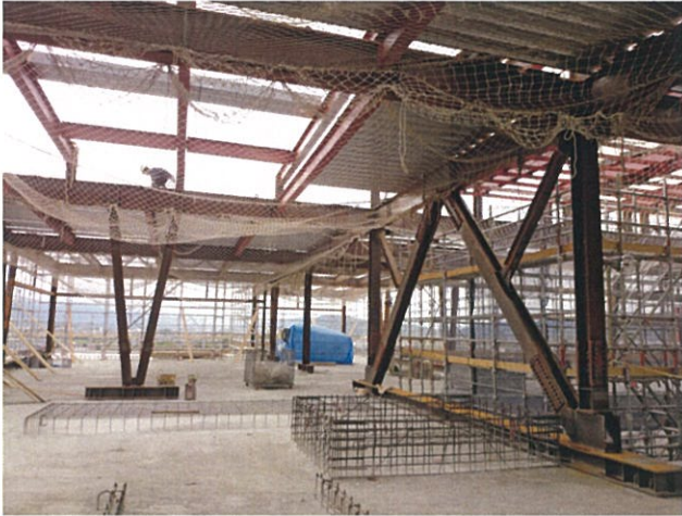
写真-3 鉄骨ブレスとV字柱
