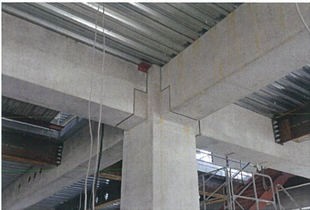
写真-5 柱-梁接合部
