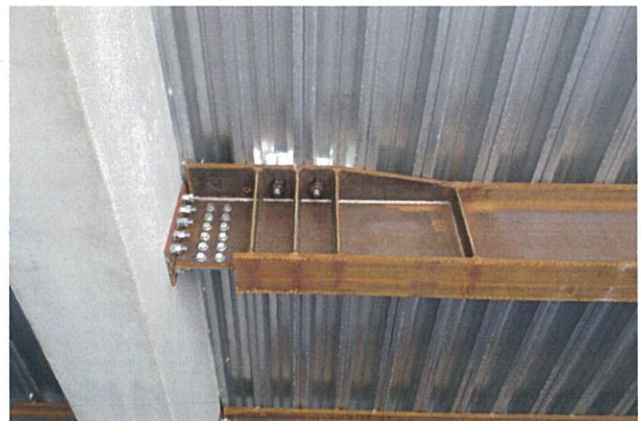
写真-2 鉄骨小梁納まり
