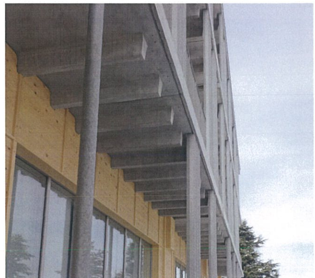
写真-8 バルコニー見上げ
