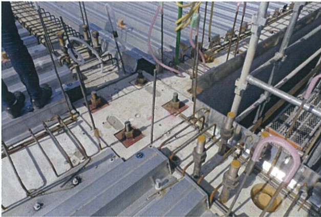
写真-4 鉄骨ブレスアンカ-ボルト
