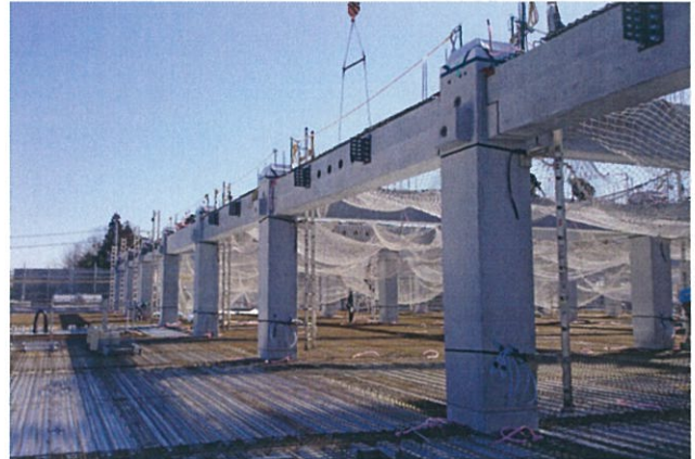
写真-1 梁とガセットプレート
