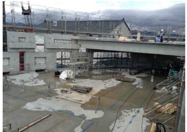
□図 3-3 S T床版建方中
