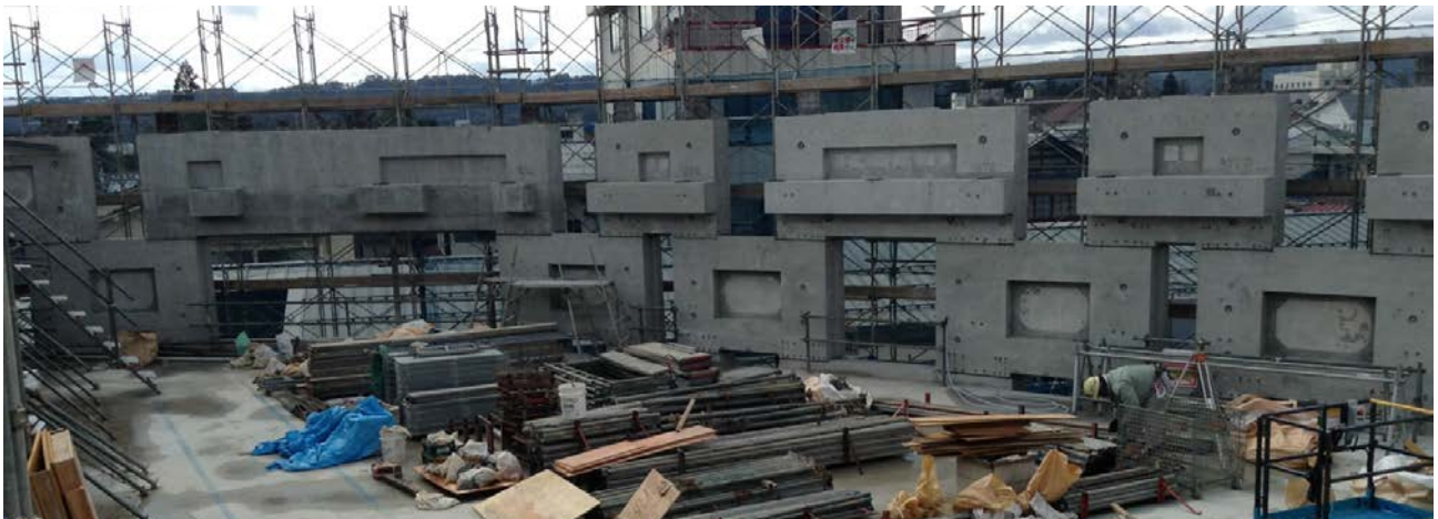
□図 2.2-3 壁パネル建方時
