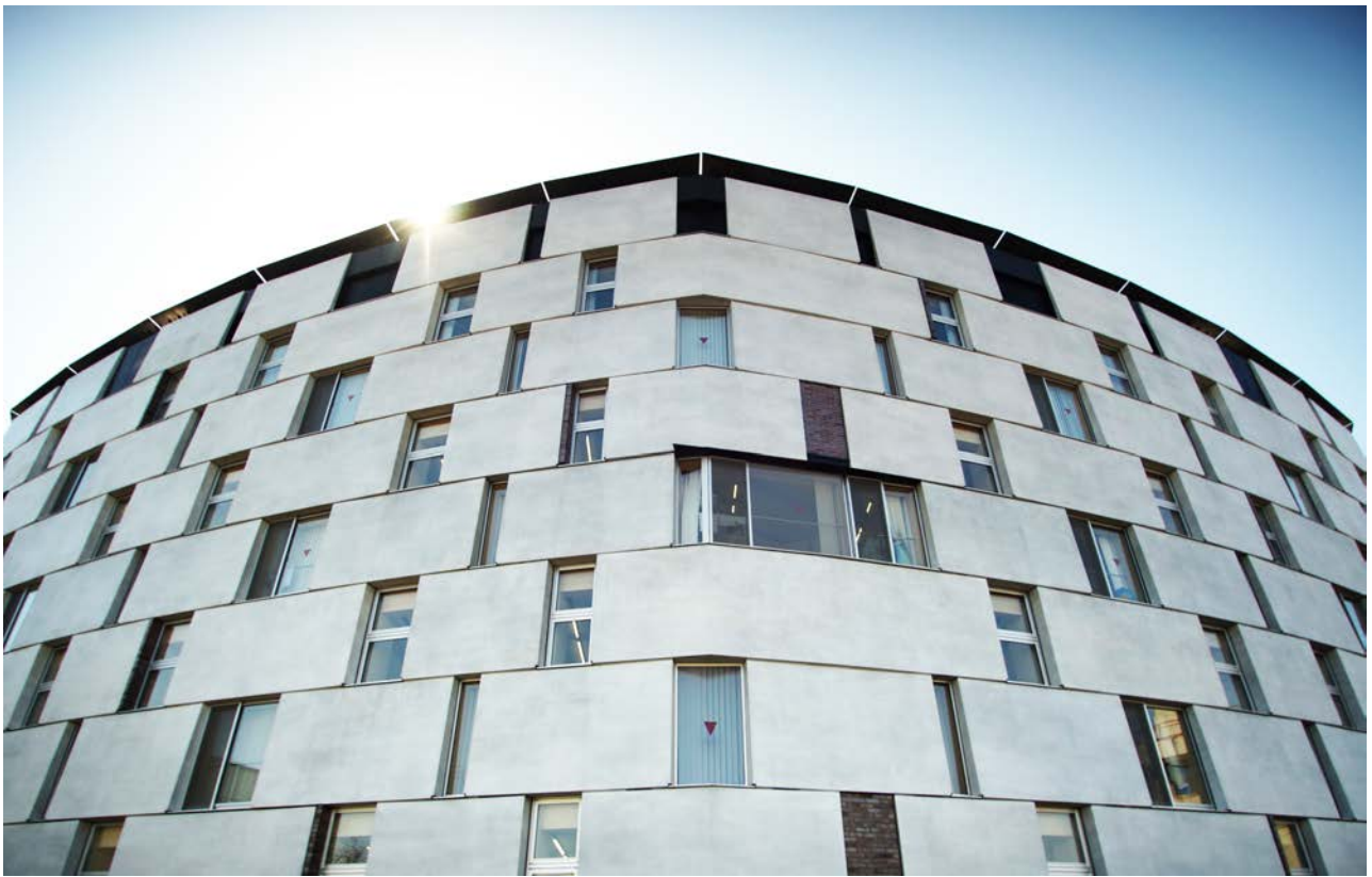
□本庁舎棟北側 PC 壁
