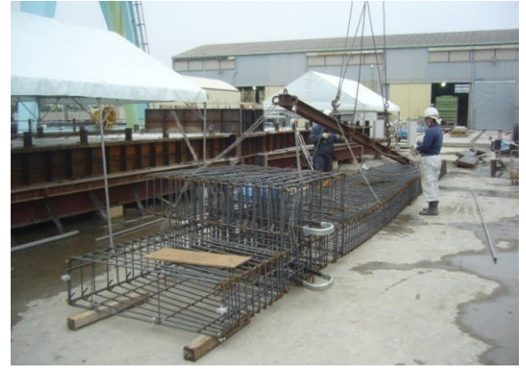
アーチ梁の配筋
