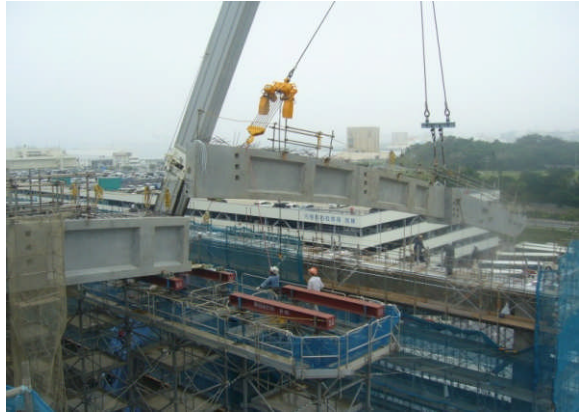
アーチ梁の架設（ブロック 1～3）
