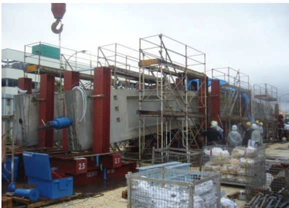
アーチ梁の地組み（2次緊張）
