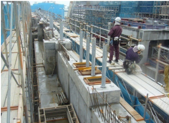
A 通り側 支承部
