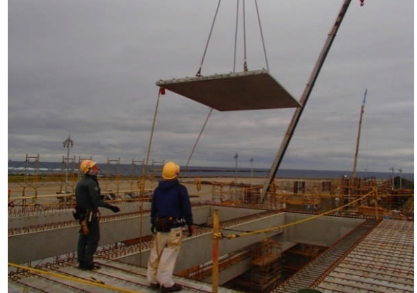
ハーフ PC 床版の架設
