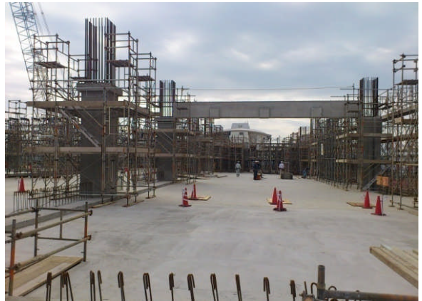
PCaPC 大梁の架設
