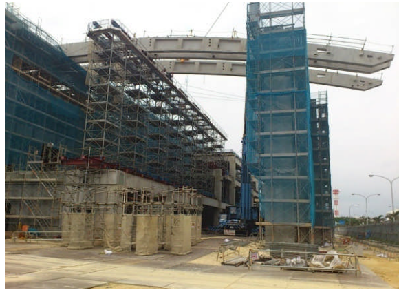
アーチ梁の架設（A-E 間）
