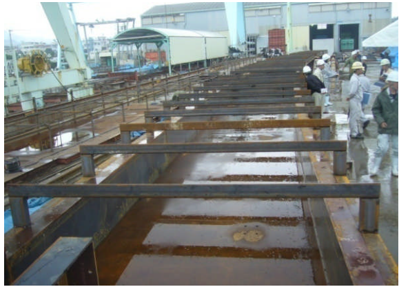
アーチ梁の鋼製型枠
