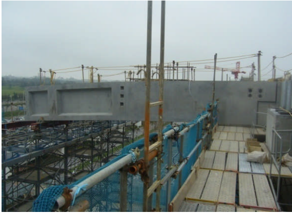
アーチ梁の架設（ブロック 4）
