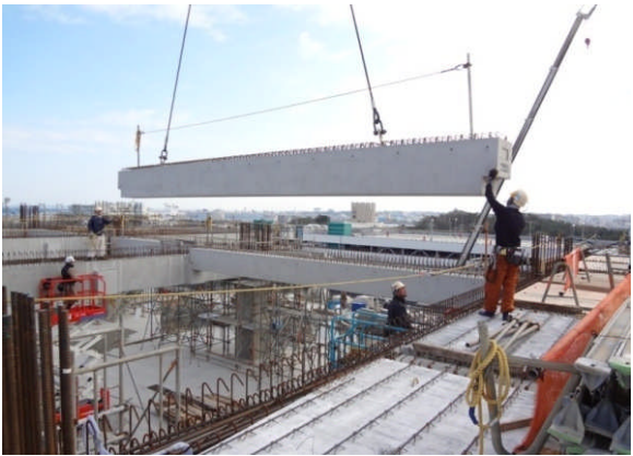
PCaPC 小梁の架設
