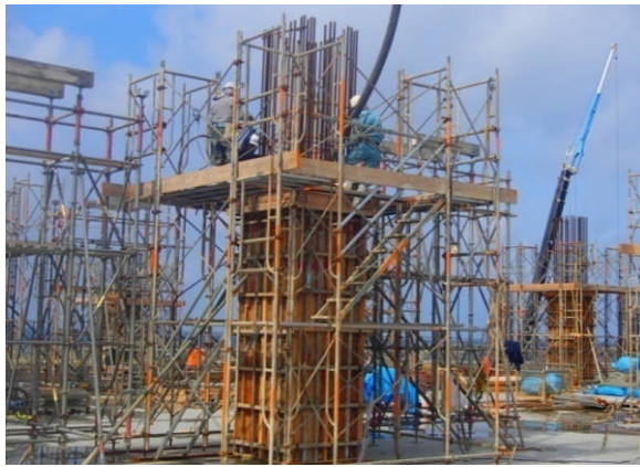
柱コンクリート打設
