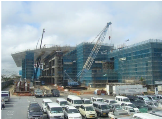
DT 版の架設（A-E 間）
