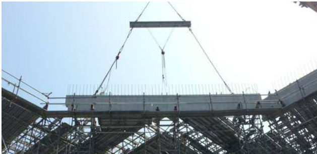
写真-7 PC梁架設状況
