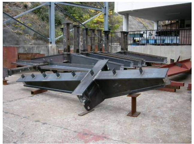
写真-10 鉄骨製作状況
