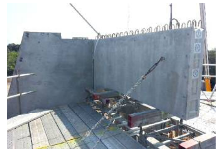
梁部材架設状況
