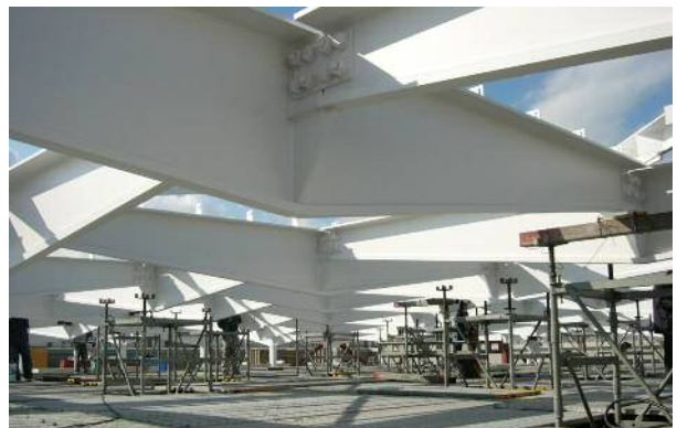
写真-11 ジャッキダウン後の状況
