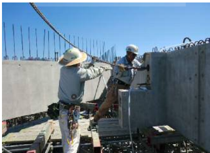
PC鋼材入線状況
