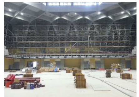
支保工解体後
