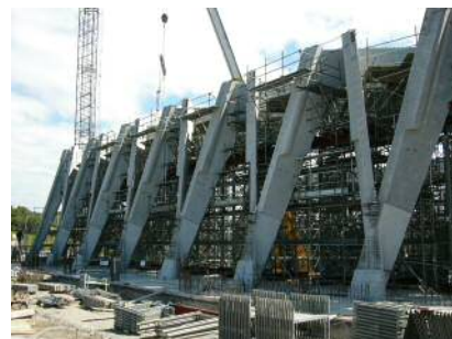
柱部材架設完了
