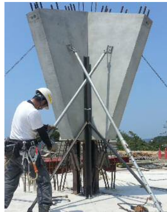
柱脚部材架設状況
