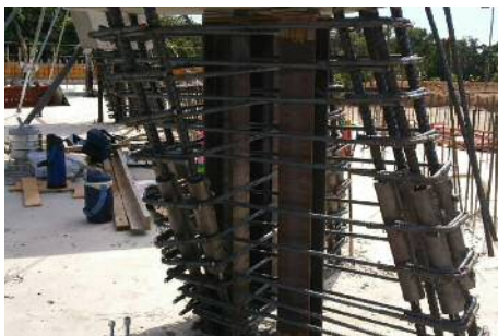
柱脚部配筋状況
