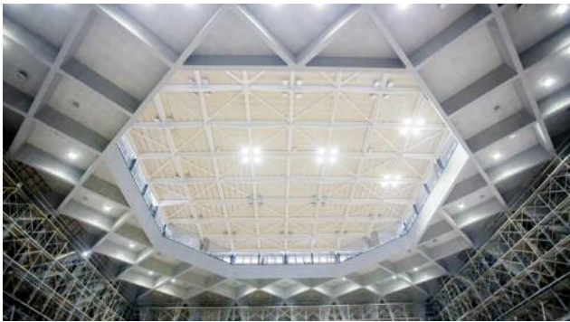
写真-8 支保工解体後
