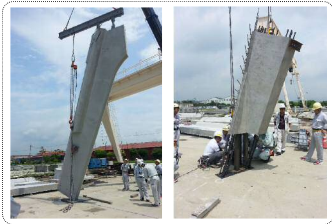
工場内 試験建てて起し状況
