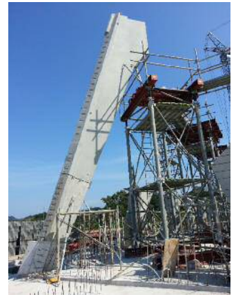
柱上部材架設状況
