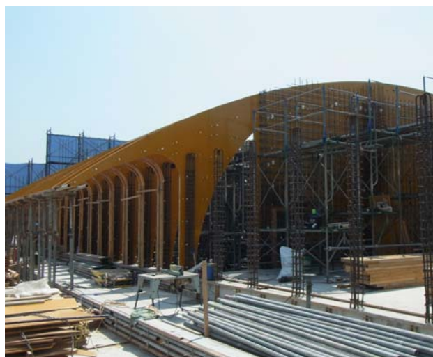
写真 12 アーチの施工風景
