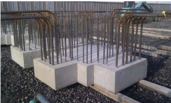
免震上部基礎のサイト PC 化
