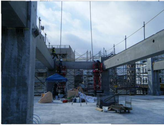
③大梁架設
