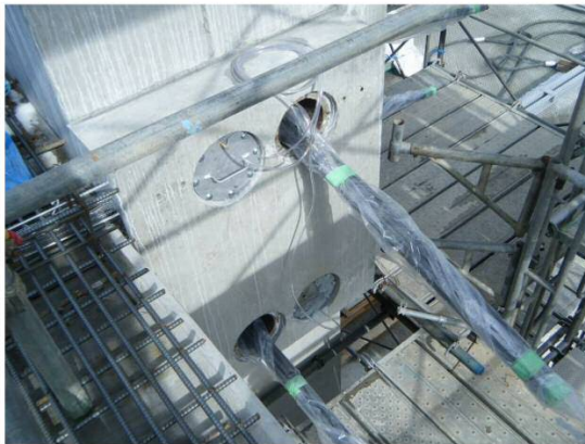
⑦大梁 2 次緊張 (PC ケーブル切断、 グラウトキャップ取り付け)
