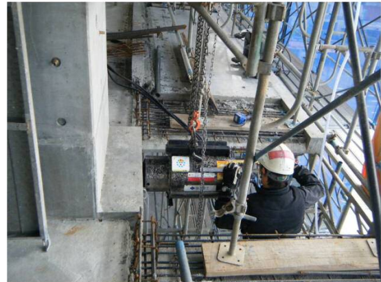
⑧大梁 3 次緊張 (PC ケーブル伸び計測)
