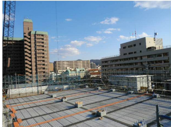
⑤床版敷設
