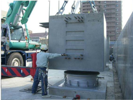
①免震ブロック架設
