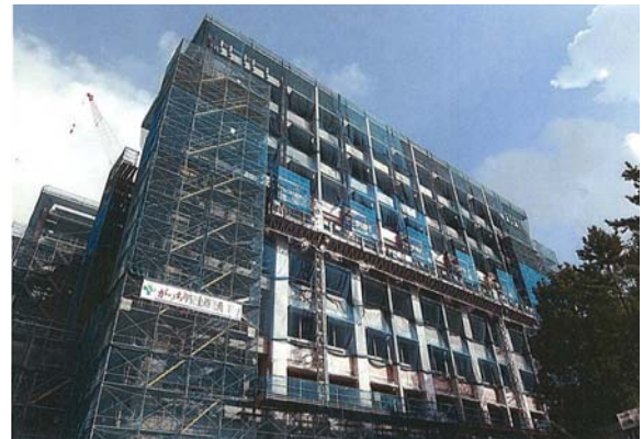
⑥ SRC 柱及び床コンクリート打設
