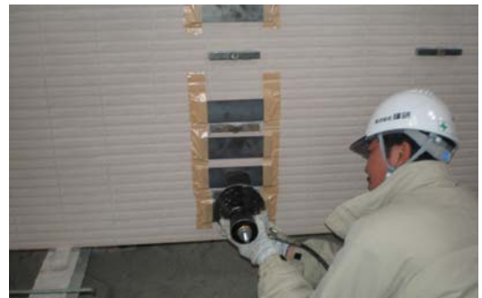
実大試験体によるタイル接着強度試験
