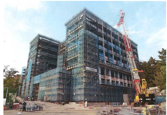
④ 建方完了
