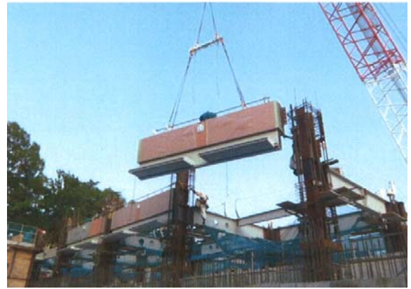
② 部材取り付け状況
