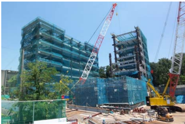
③ 建方進行中
