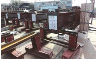
柱鉄骨に柱鉄筋を地組
