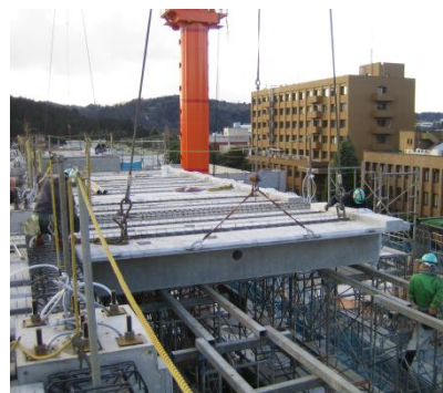
片持ち床版の施工状況
