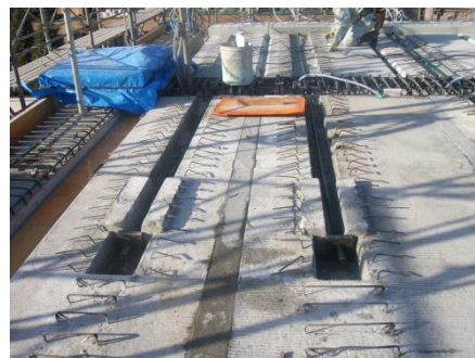
PC 鋼線配線部
