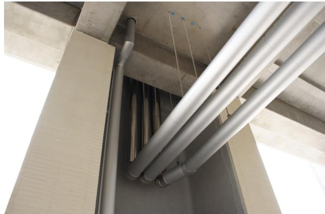
写真)コの字柱 設備配管配置後
