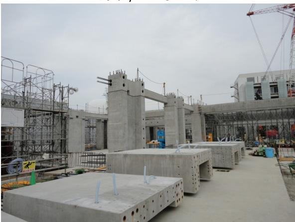
写真5)桁梁 建方
