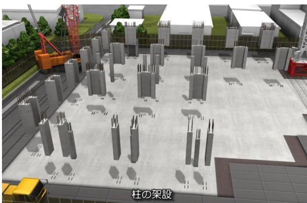
STEP2:柱の設置、柱主筋のグラウト
