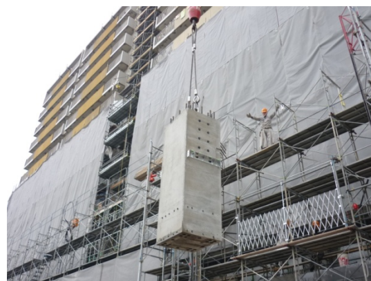
写真ー9 PC柱建方
