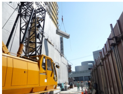
写真-2 PC梁設置
