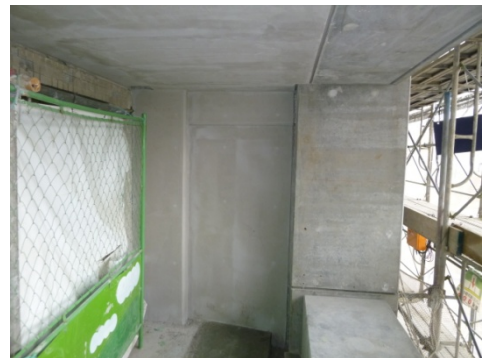
写真-7 コンクリート打設後
