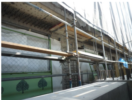
写真-1 後施工アンカー
