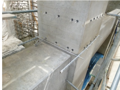
写真-5 柱設置状況
