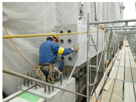
写真ー10 PC梁建方
