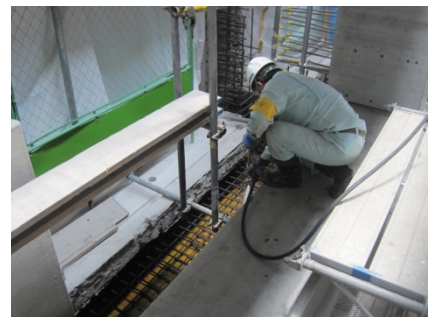
写真-3 現場打ち床打設前
