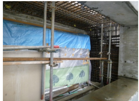
写真-6 コンクリート打設前
