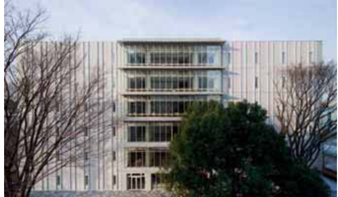
南側外観（PCF 版によるファサード）
