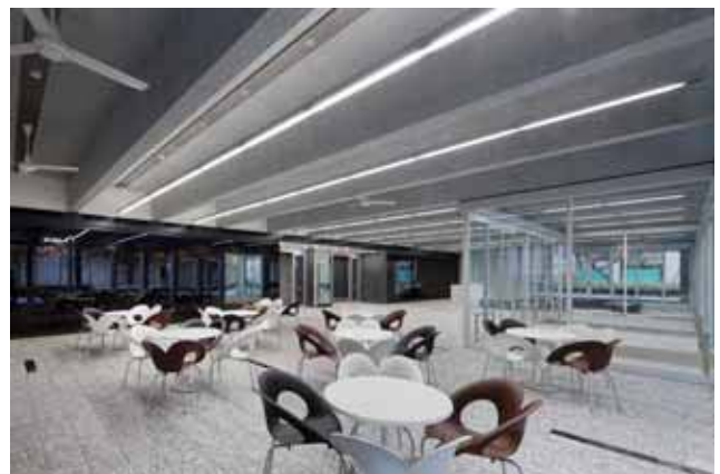
エントランスホール：ST版を生かしたデザイン
