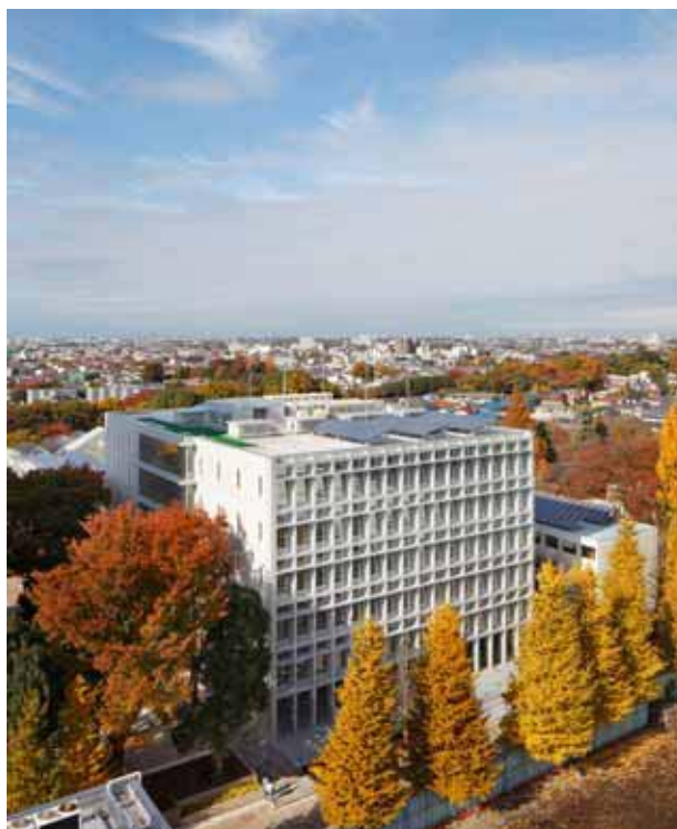
5 号館全景写真(東側)
