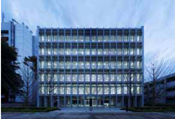
東側外観（細柱、ST 床板、ライトシェルフによるファサード）
