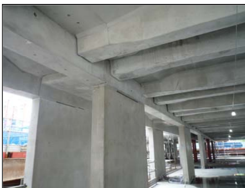
写真-3 鋼管柱と PCaPC 間柱
