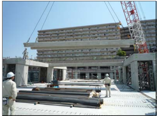
写真-4 施工中写真
