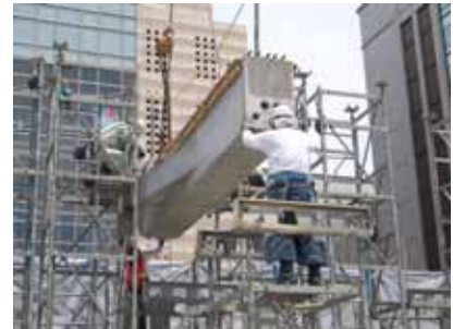
写真10-3 分割PC梁建方
