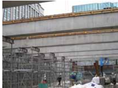
写真10-11 PC梁一体化
