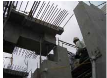
写真10-6 分割PC梁建方
