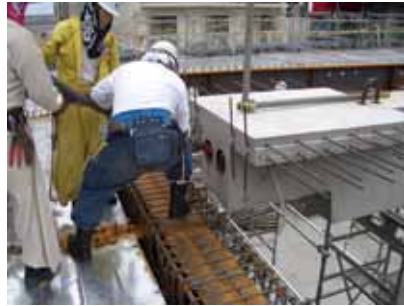
写真10-8 PC鋼線配線
