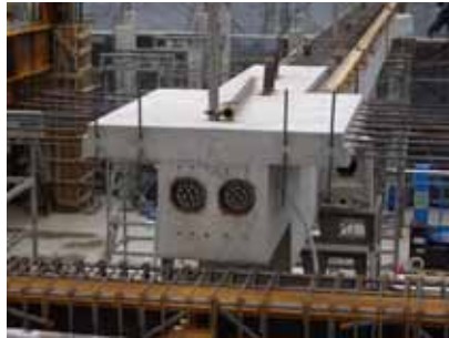
写真10-10 PC鋼線緊張完了
