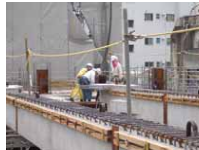
写真10-5 分割PC梁建方
