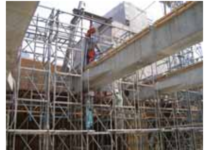
写真10-12 ジャッキダウン
