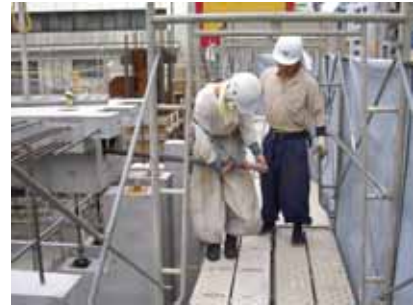
写真10-9 PC鋼線配線
