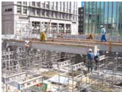
写真10-4 分割PC梁建方
