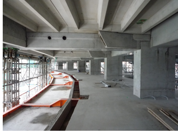
写真7 平場部分のPCa床版
