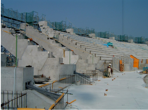
写真6 段床部のPCa床版
