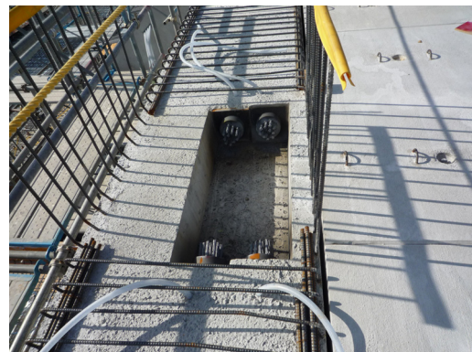
写真5 桁行方向のPC 鋼線アンカー部
