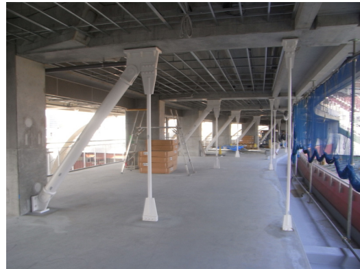
写真 9 鉄骨吊床
