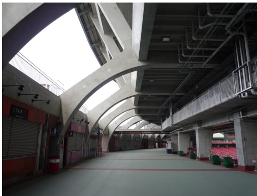
写真4 放射方向のPCa 架構
