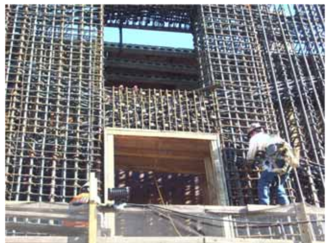
図 13 境界梁におけるX型配筋 Courtesy of Prof. Jack Moehle
